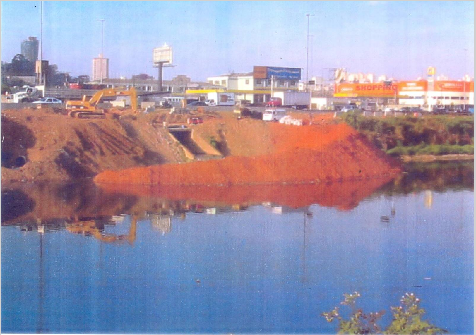
Ensecadeira para execução de desemboque de Córrego no Rio Tietê
