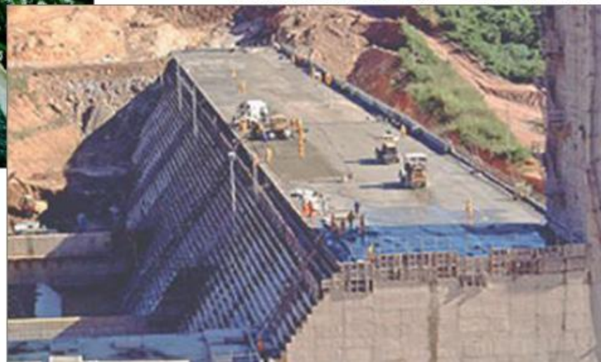
BARRAGEM EM CCR - CONSTRUÇÃO
