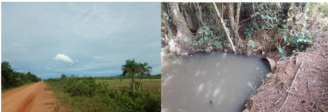
Figura 7. Pequeno acúmulo de água devido à construção de estrada, constatado no ponto código 6761.
