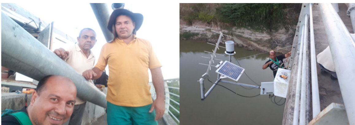
Foto 17: Tenente Coronel James fazendo rapel na manutenção da PCD. Foto 18: Equipe na Ponte, em atividade de manutenção.
