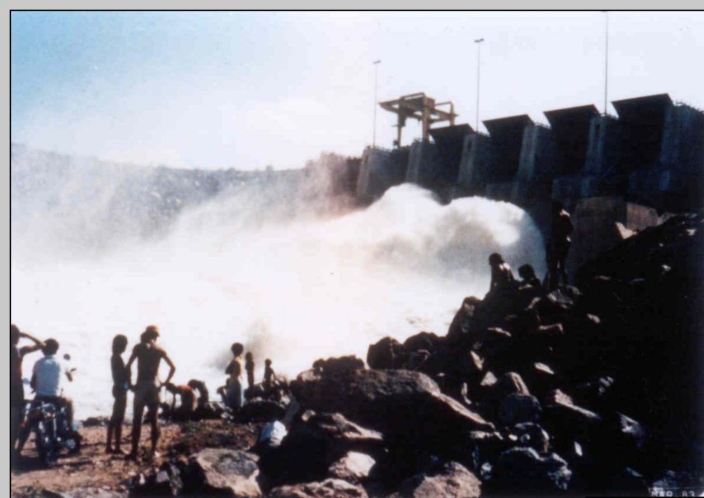
Vertedor em Operação
