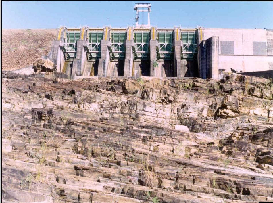
UHE - Jaguará Vista de Jusante de Vertedor
