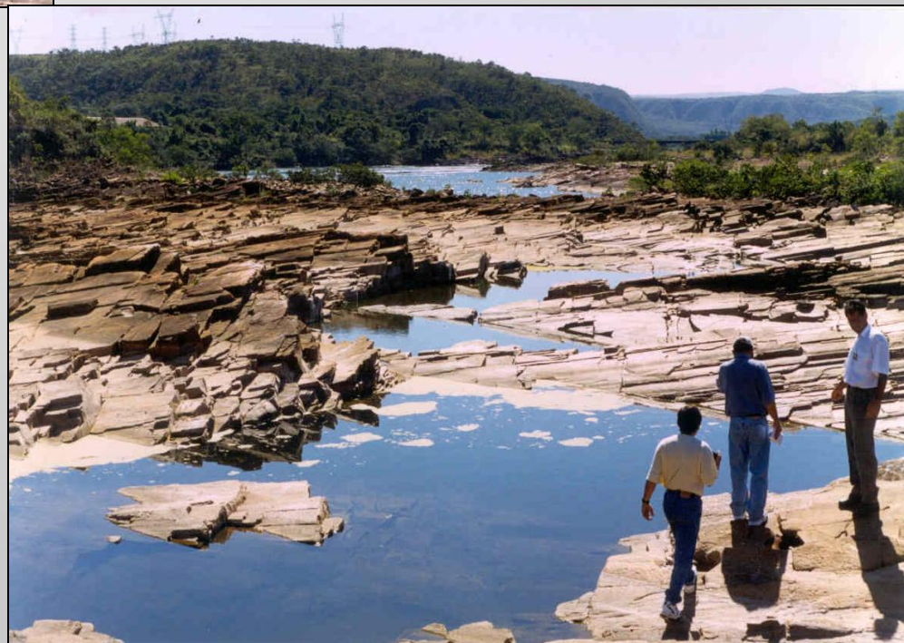
UHE - Jaguará Formação de “piscinas” à jusante do vertedor
