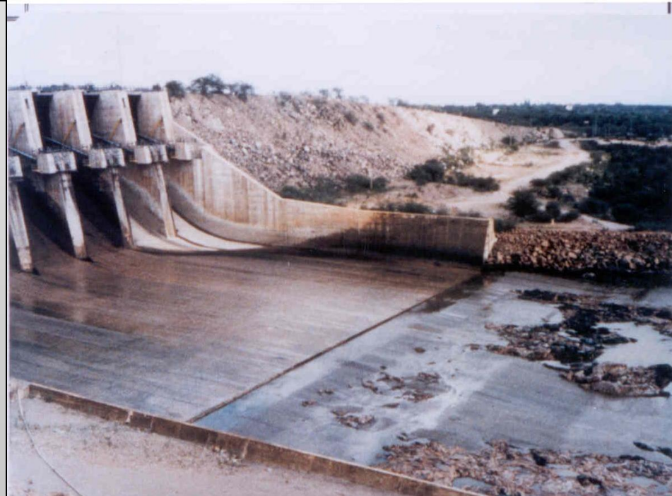
Após execução do reparo
