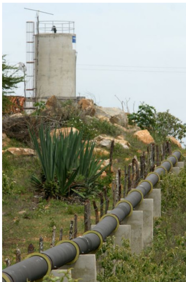
Adutora na região do Cariri/CE
