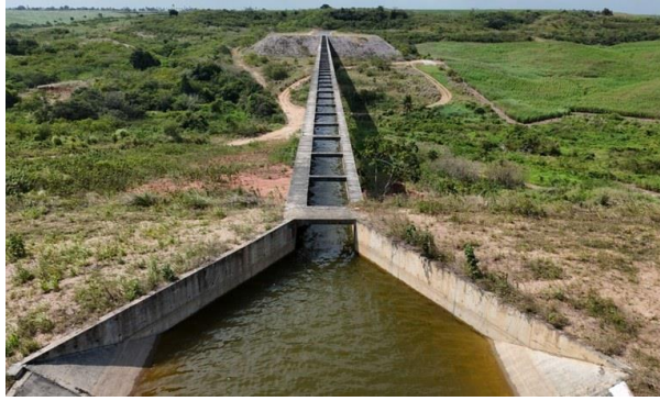
11 - Conclusão do Lote 2 do Canal Acauã-Araçagi possibilitará passagem de águas por cerca de 100 km - Foto: Governo da Paraíba
