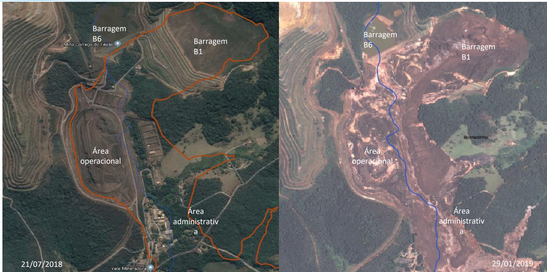
Área da Vale atingida pelo rejeito da Barragem B1 – Mina Córrego do Feijão. Brumadinho/MG.
