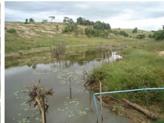
Foto 04 - Reservatório da barragem da Foto 03.
