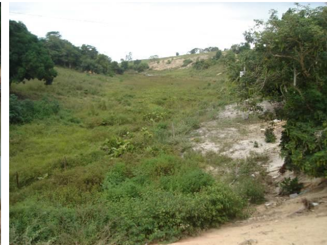
Foto 02 - Jusante da barragem da Foto 01 e montante da foto 03.
