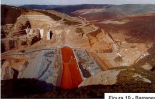
Figura 19 - Barragem de enrocamento com núcleo impermeável de asfalto UHE Foz de Chapecó.
