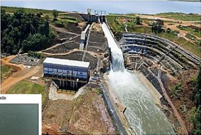
Figura 27 – Vertedouros de Cachoeira Dourada
