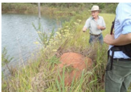
Figura 22 – Cupinzeiro no coroamento da barragem Fonte: Banco de Imagens ANA
