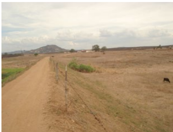
Figura 14 – Zona de vegetação verdejante no talude de jusante da barragem Fonte: Banco de Imagens ANA
