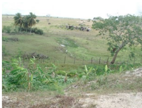
Figura 11 – Surgência e zona alagada em zona imediatamente a jusante da barragem Fonte: Banco de Imagens ANA
