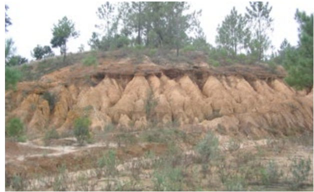
Figura 27 – Forte ravinamento dos taludes do reservatório
