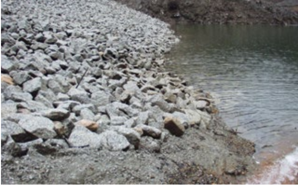
Figura 8 – Curvatura na linha de interseção do espelho de água com o paramento de montante Fonte: Banco de Imagens ANA
