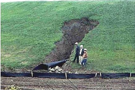
Facilitador: Rui Fonte: 319 Medford Genstar piping failure HVA larger
