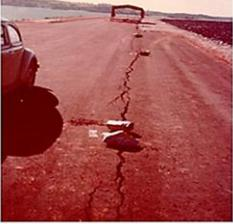
Figura 48 – Recalque localizado, perceptível na crista da barragem
