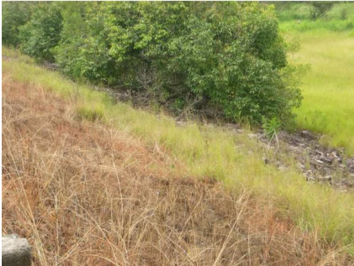
Detalhe do enrocamento de proteção no pé da barragem
