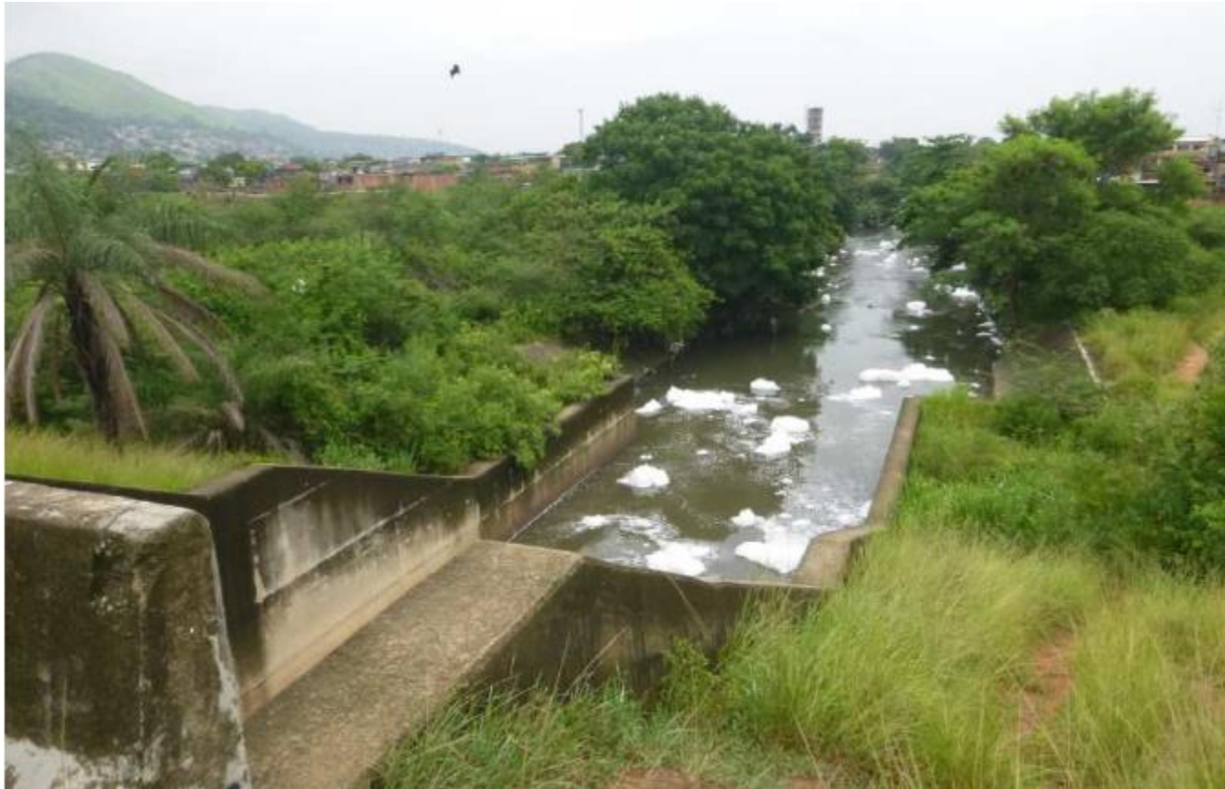
Vertedouro do rio Sarapuí – vista para jusante
