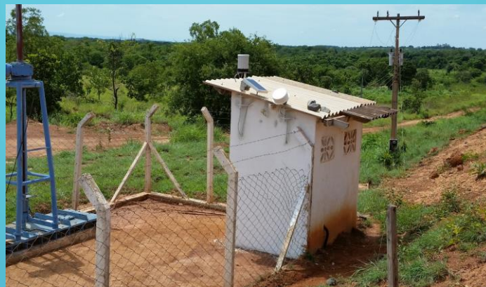
Estação Hidro Barramento
