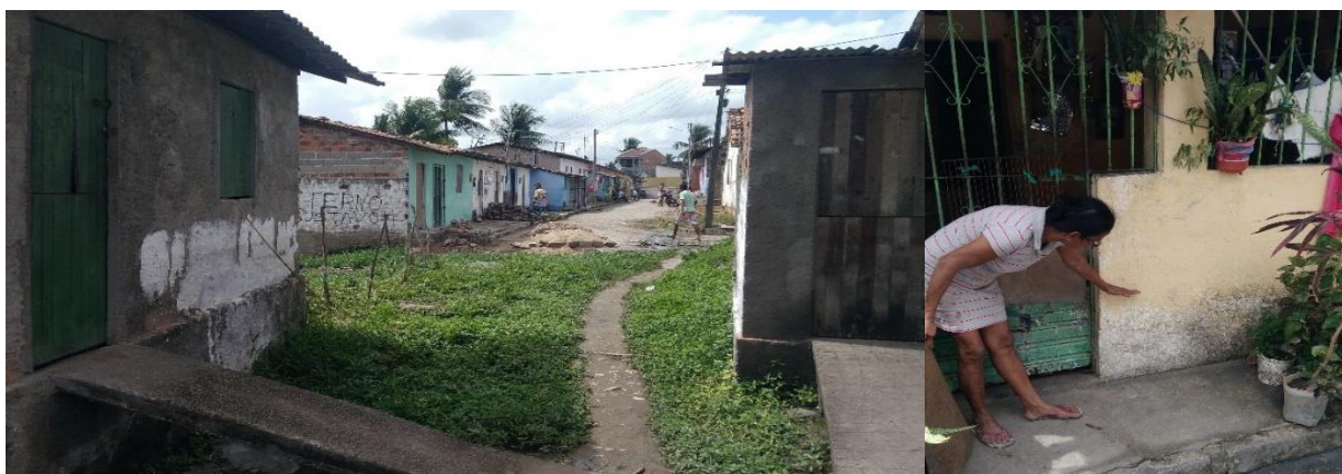
Figura 51. À esquerda, moradias em área de risco a inundação em Cajueiro/AL; e à direita, moradora indicando onde a água chegou durante a cheia de 2010 (Ponto A)
