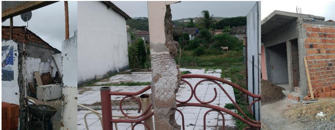
Figura 44. Casas destruídas pela enchente de 2010 e novas construções nas margens do rio Paraíba do Meio em Quebrangulo/AL
