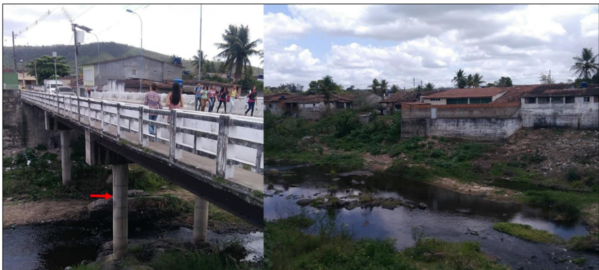
Figura 47. À esquerda, a ponte da cidade (Ponto K) onde está localizada a PCD e é indicado o nível que a água chegou durante a cheia de 2017; à direita, moradias construídas próximas do leito do rio (Ponto L)
