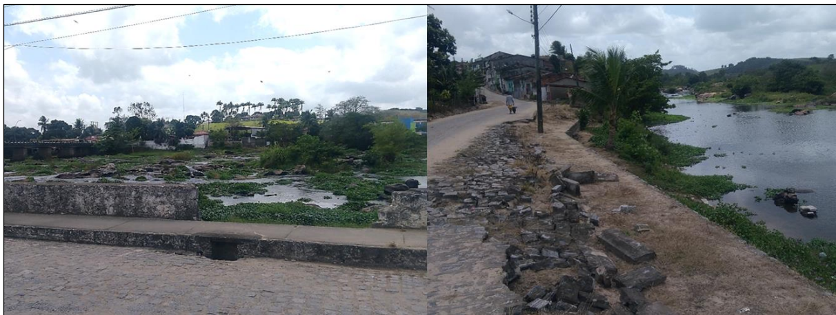
Figura 54. À esquerda, abertura na parede do canal do rio por onde normalmente a água começa a transbordar (Ponto E); e à direita, calçada arrancada pela cheia de 2017 (Ponto H)
