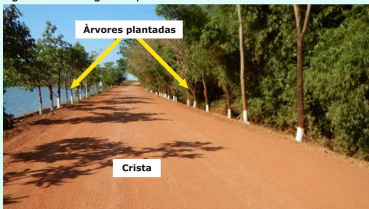
Recomenda-se retirar a vegetação encontrada na região a jusante da barragem, deixando uma **faixa de no mínimo 10 metros, a partir do pé do talude jusante**. Essa ação tem a função de facilitar a **visualização de anomalias e a inspeção da barragem**. Porém, antes da retirada, deve-se verificar se a vegetação nessa faixa não possui raízes no talude, que poderiam prejudicar a estrutura da barragem. Após a remoção das árvores com as raízes, deve-se preencher os buracos e compactá-los
