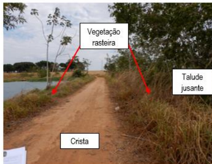
Figura 5 - Crista e taludes com vegetação rasteira
