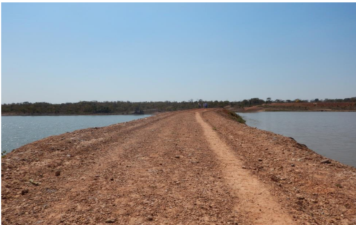
Figura 5. Barragem Localizada em Várzea Grande, MT
