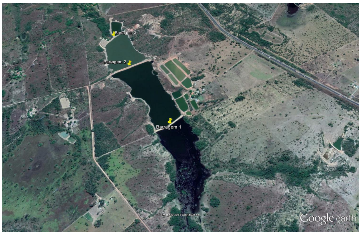
Figura 3. Barragens Utilizadas para a Análise da Influência Negativa das Barragens Localizadas em um Mesmo Rio
