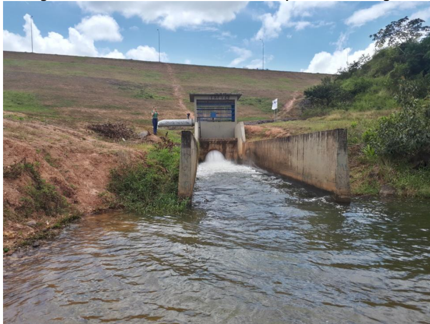
Figura 16 - Ponto 7: Saída da válvula dispersora - Barragem
