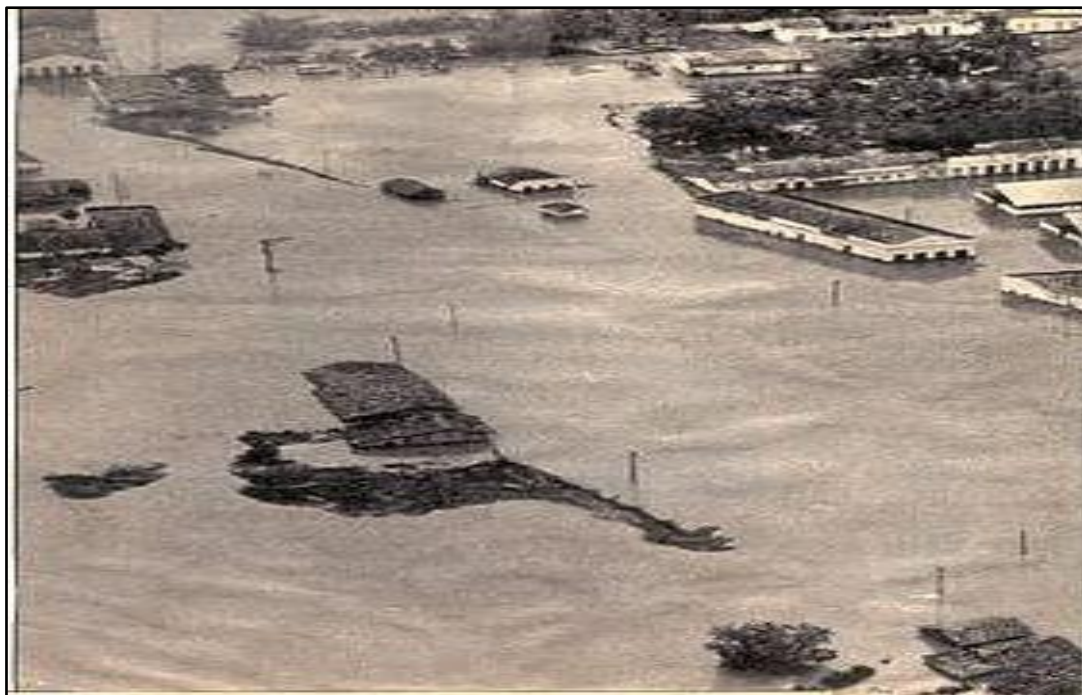
Figura 16 - Enchente de 1969 no município de São José da Laje - Estado de Alagoas. Fonte: HISTÓRIA DE ALAGOAS (2016).
