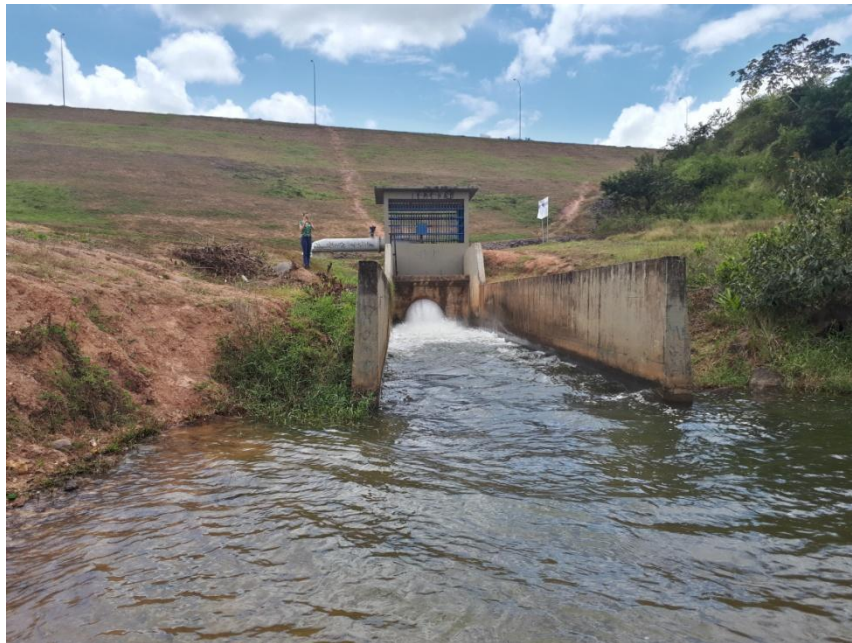
Figura 61. Ponto G: saída da válvula dispersora da barragem Jaime Umbelino.
