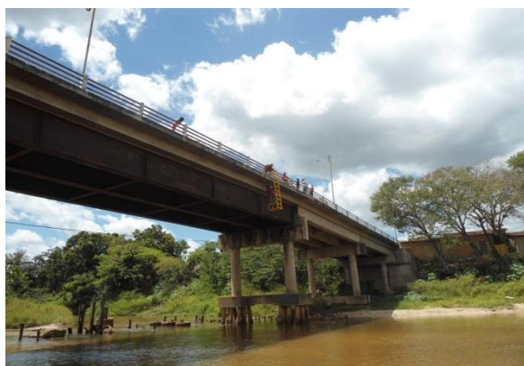
Fig 19 - Instalação do radar
