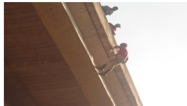
Fig. 25 - Instalação do radar
