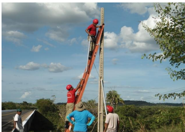
Fig 8 - Instalação da Estação Iguara próximo a ponte
