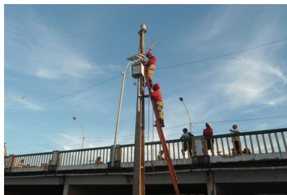
Fig. 40 - Instalação da PCD
