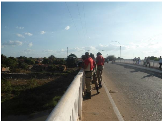
Fig. 66 – Colocação da escada para passar a fiação
