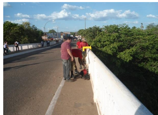
Fig. 69 – Colocação da escada para instalação do radar
