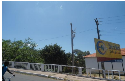
Fig. 57 – PCD instalada ao lado da loja de vender ração.
