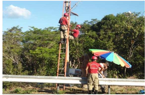
Fig. 11 - Instalação da PCD na Estação Iguara
