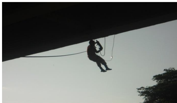
Fig. 24 - Instalação da fiação
