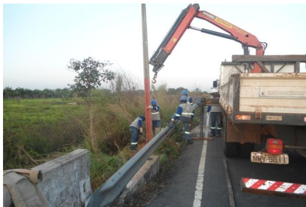
Fig. 22 - Instalação do poste
