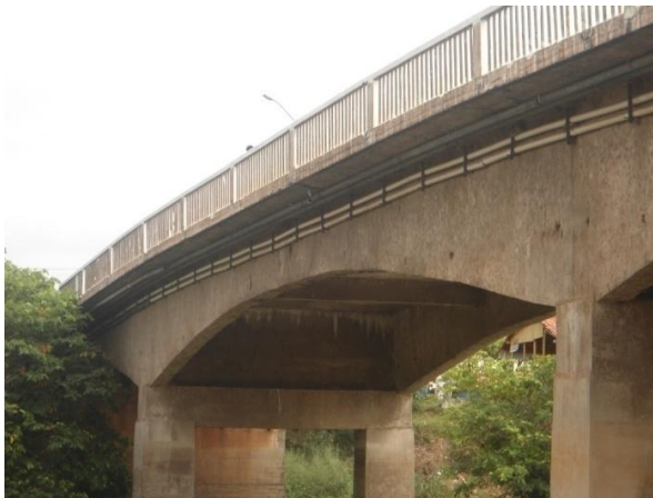
Fig 31 - O radar instalado na ponte
