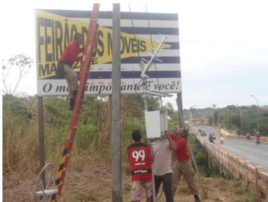
Fig. 75 – Colocando a PCD no poste.
