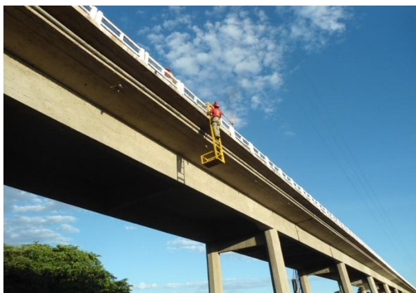
Fig. 36 - Instalação do radar e da fiação
