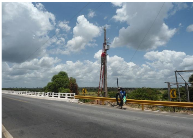
Fig. 34 - Instalação da PCD ao lado da ponte
