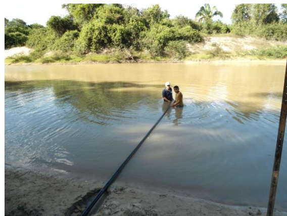
Fig 6 - Instalação do Medidor de Pressão
