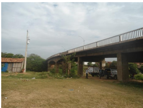
Fig. 29 - Vista do local da instalação da PCD.
