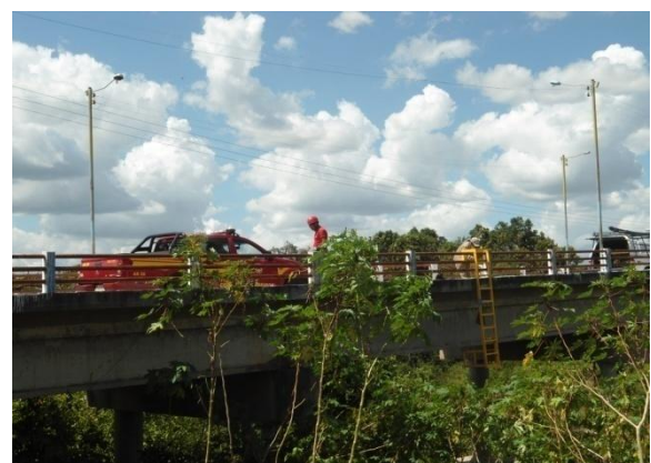
Fig 20 - Instalação a fiação
