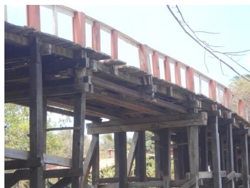
Fig. 54 - Radar instalado no vão central da ponte.
