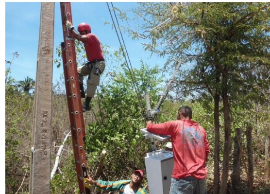
Fig. 47 - Instalação da PCD.
