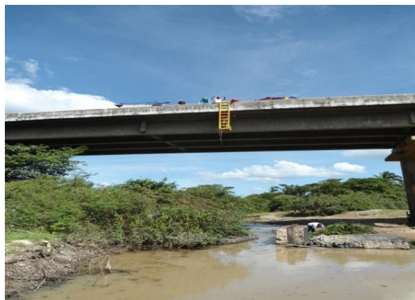
Fig. 9 - Colocando a fiação na Estação Iguara
