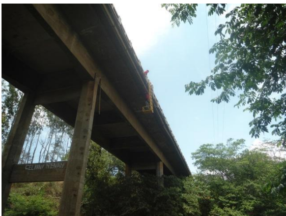
Fig. 73 – Instalação da fiação
