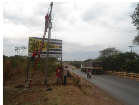
Fig. 76 – Instalação da PCD.
