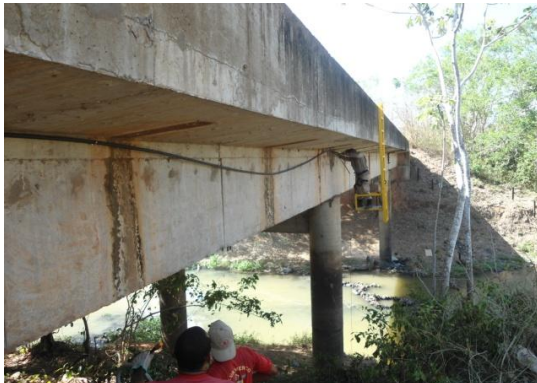
Fig. 46 - Instalação da fiação e do radar.
