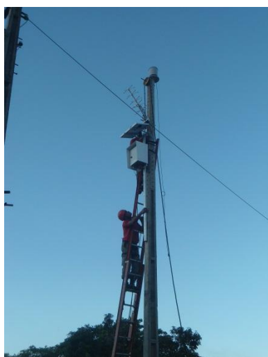
Fig. 63 – Prendendo a PCD no poste
