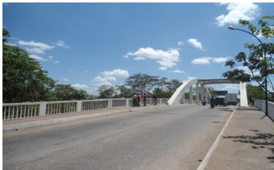
Fig. 56 – Ponte onde encontra-se instalada as réguas
