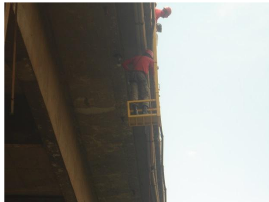
Fig. 72 – Instalação do radar.
