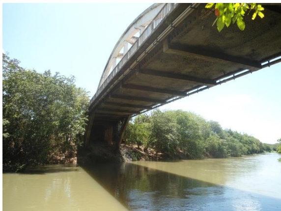
Fig. 62 – Radar instalação em baixo da ponte encanação existente.
