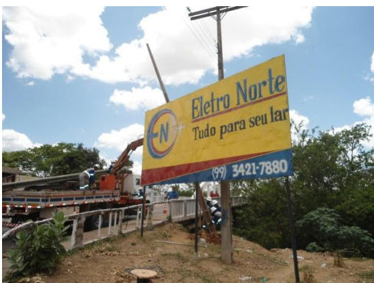
Fig. 60 – Instalação do poste pela CEMAR.
