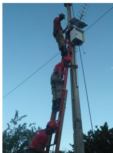
Fig. 64 – Ajustes finais da PCD no poste
