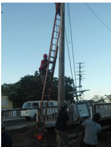
Fig. 62 – Subida da PCD no poste
