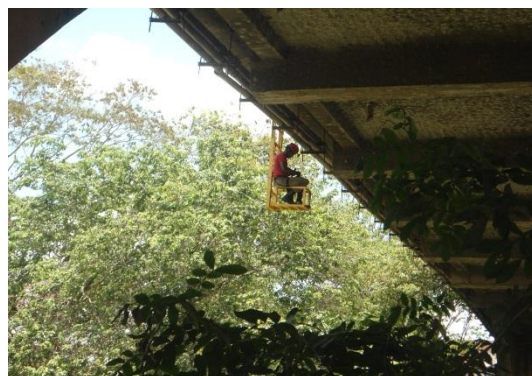
Fig. 59 – instalação do radar.
