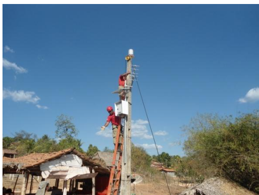
Fig. 51- Instalação da PCD.
