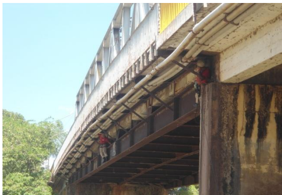
Fig. 41 - Instalação do radar
