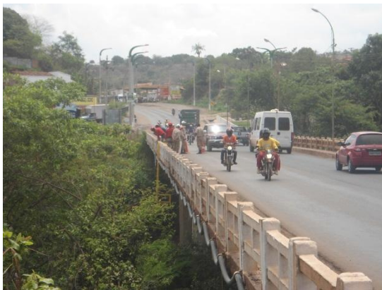
Fig. 71 – Colocação da escada para passar a fiação
