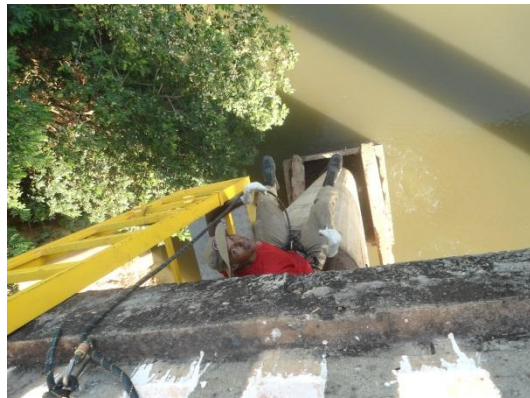
Fig. 67 – instalação do radar
