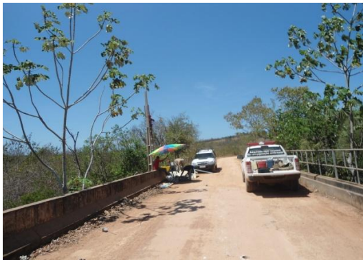
Fig. 44 - local de instalação da PCD.
