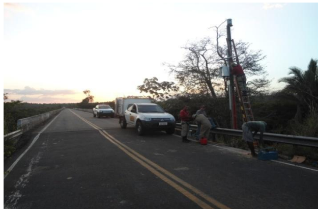
Fig. 23 - Instalação da PCD com a ponte ao fundo
