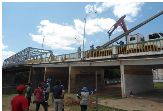
Fig. 39 - Colocação do poste ao lado da ponte
