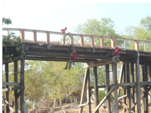
Fig. 53 - Instalação do radar e da fiação.
