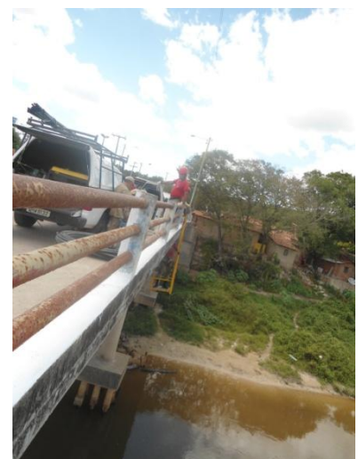
Fig.18 - Equipe instalando o radar
