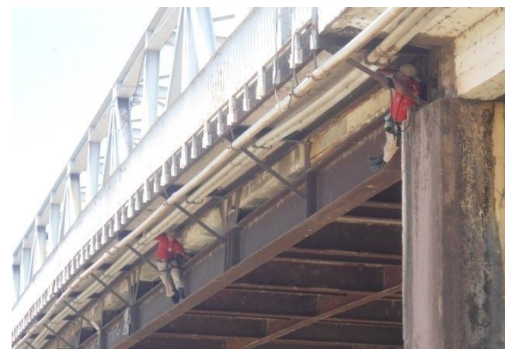
Fig. 42 - Instalação da fiação.
