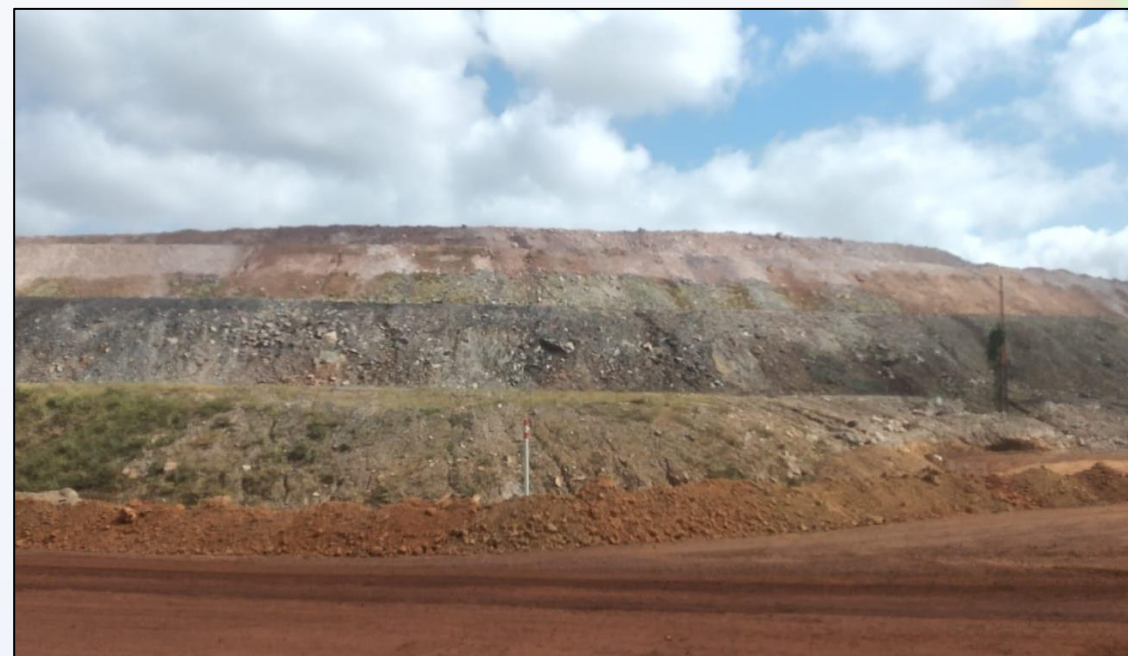
Barramento da Aurizona – Equinox Gold
