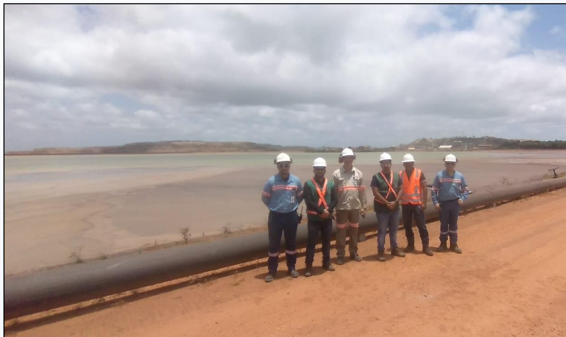
Barramento da Aurizona – Equinox Gold
