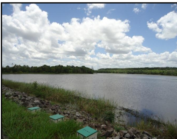
Foto IV.5.1-3: Talude de jusante e parte da área de inundação.
