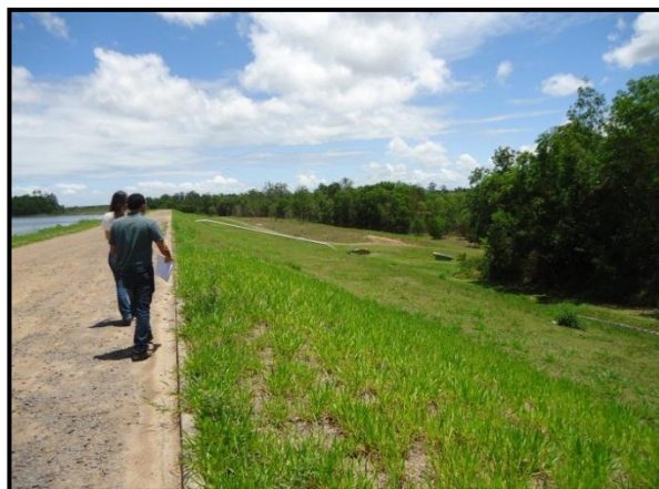
Foto IV.5.1-2: Talude de montante.
