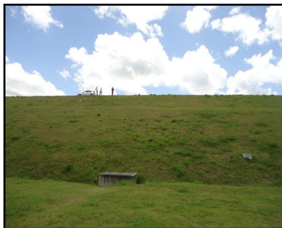
Foto IV.5.1-4: Talude de montante.
