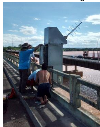
Figura IV.4: Montagem da PCD em Linhares
