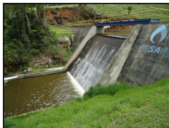
Foto IV.5.1-9: Talude de montante.
