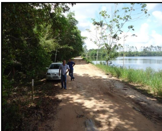
Foto IV.5.1-6: Talude de jusante e parte da área de inundação.
