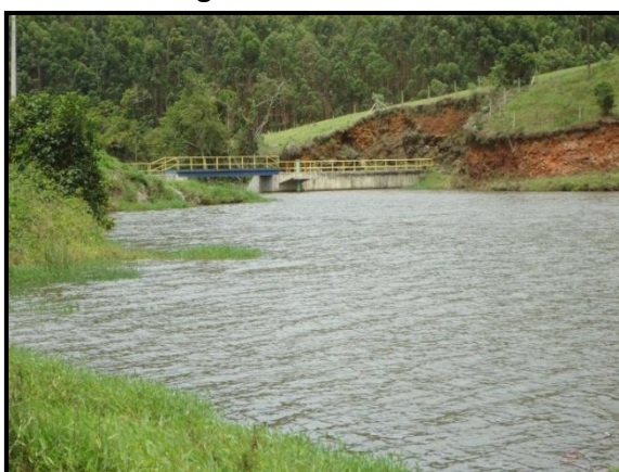
Foto IV.5.1-8: Talude de jusante e parte da área de inundação.
