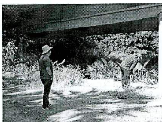
Figura 7 – Cabo do sensor aterrado e rompido, PCD Fazenda Angicos.
