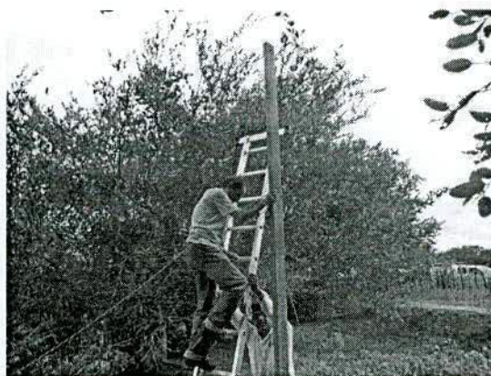
Figura 2 – Instalação do novo Sensor de pressão, PCD Gov. Dix-Sept Rosado.
