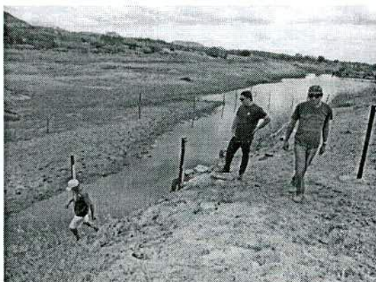
Figura 11 – Local de instalação do sensor de pressão, PCD Jucurutu.
