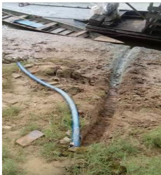
*Figura 28 - Prolongando o cabo do sensor para chegar ao rio*
