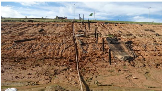
*Figura 31 - : Condução do cabo do sensor em tubos de PVC*
