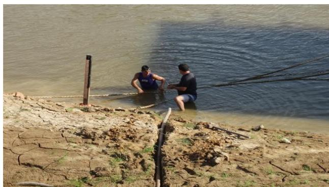
*Figura 32 - Fixação do sensor dentro do rio*
