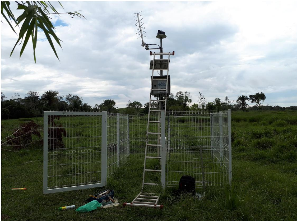
**Figura 33** – Reposicionamento da antena Goes no Riozinho do Rola
