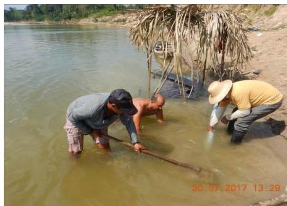
**Figura 81** – Desassoreando a mangueira do sensor da PCD do Seringal São Luiz.
