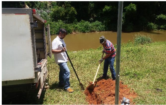
Foto 4.1 – Escavação para retirada do transdutor de pressão.
