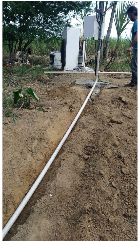
Foto 4.6 - Reinstalação do transdutor de pressão em tubulação de PVC.
