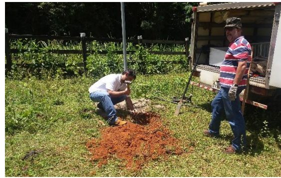
Foto 4.2 – Demolição da estrutura de fixação da haste de sustentação da PCD.
