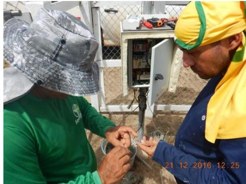
Foto: Manutenção do sensor de pressão de PCD ponte do Tacutu
