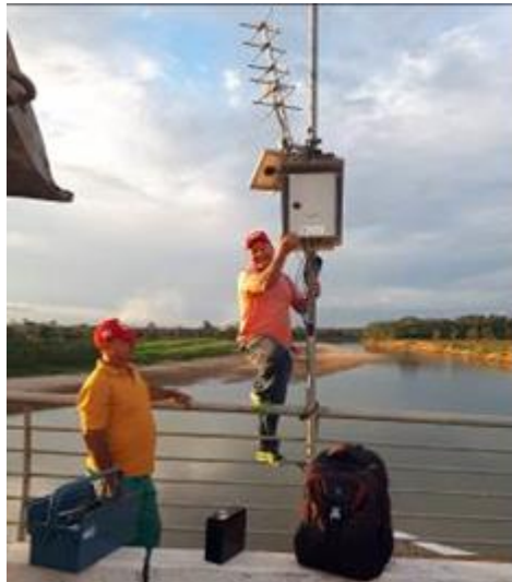
Fotos 18 e 19: Troca da bateria da PCD na Ponte de Tarauacá e remoção da PCD do Seringal Mucuripe.
