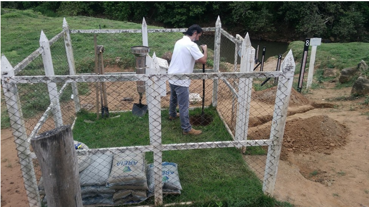
Foto 4.2 – Foto da preparação da base da PCD dentro do cercado da estação convencional.
