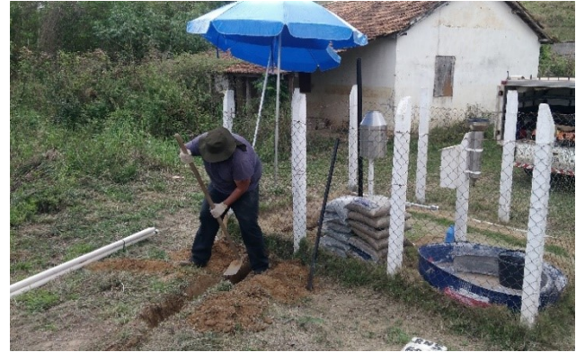
Foto 4.3 – Fotos da instalação da PCD em Nova Venécia e preparação da base de proteção do transdutor de pressão.
