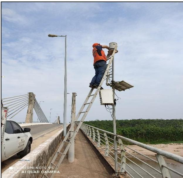
**Figura 6 - Manutenção da PCD da Ponte de Tarauacá.**
