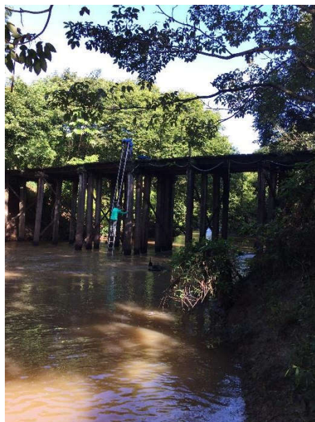
Figura 05 - Reinstalação tubulação e sensor de nível – Porto Calvo – Agosto/2020
