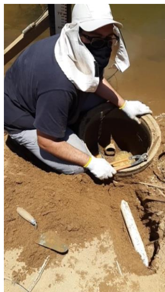
Foto 05 - Limpeza da caixa de passagem para retirada do transdutor de pressão.
