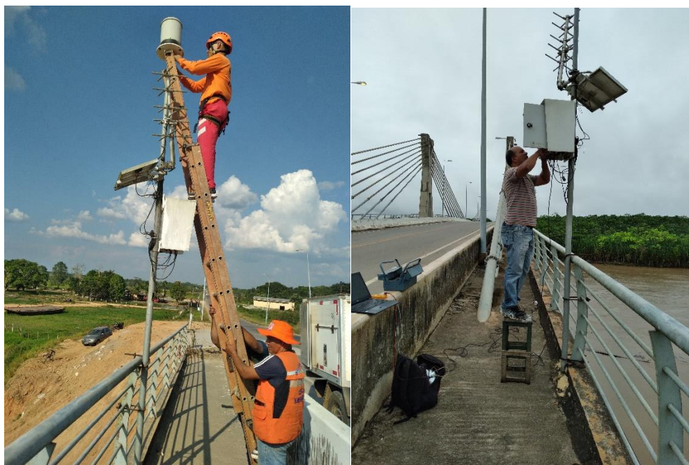
Foto 4: Manutenção corretiva da Plataforma de Coleta de Dados no Município de Tarauacá - Acre.
