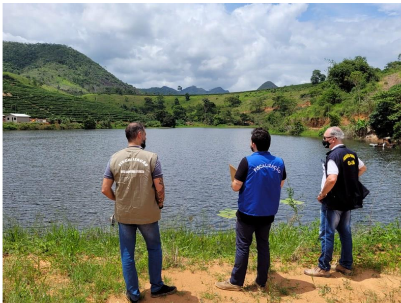
Figura 5.5: Visita técnica para inspeção visual em barragens
