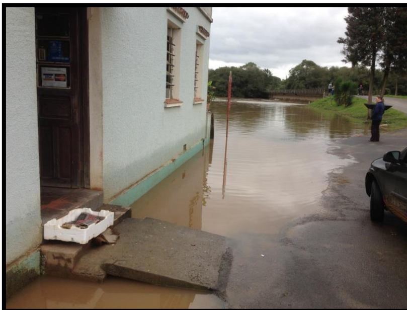
Figura 40- Imagem indicando a primeira construção atingida pela enchente
