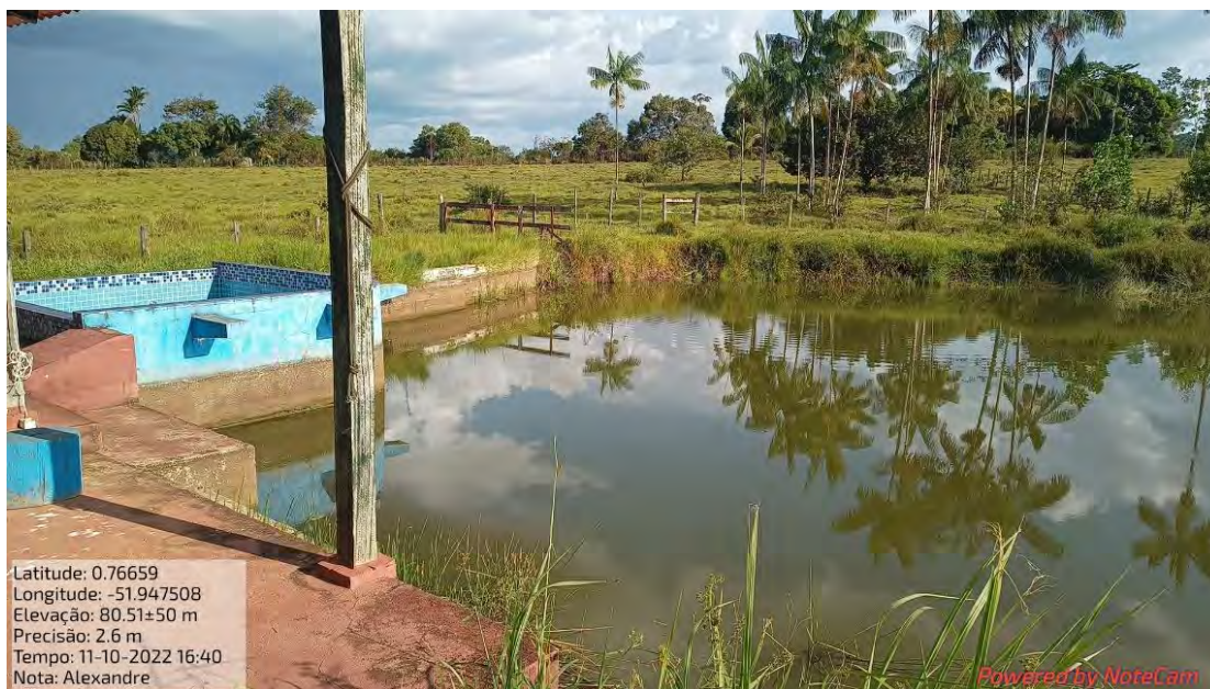
Fotografia 7: Talude de montante de concreto.
