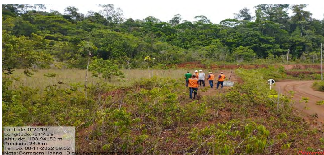
Fotografia 77: Talude jusante e crista com vegetação.
