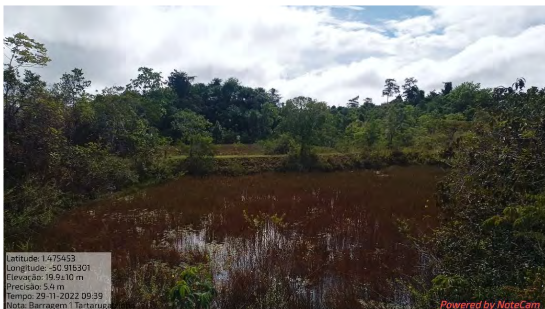
Fotografia 27: Tanques de piscicultura à jusante da barragem.
