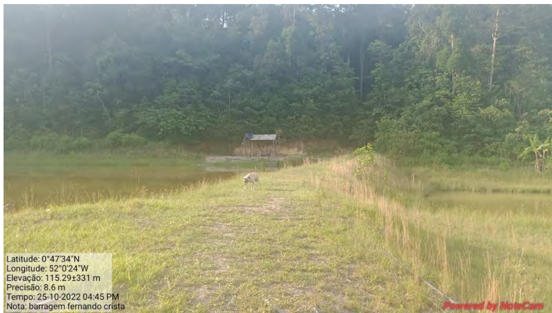
Fotografia 45: Crista da barragem Desconhecida 3- Fernando Duarte.
