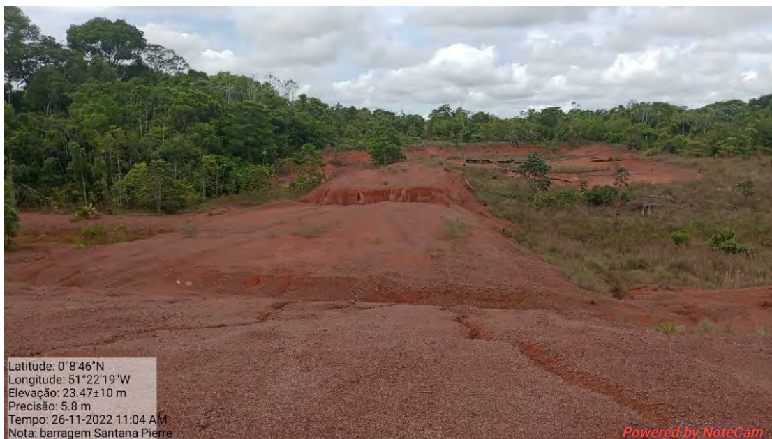
Fotografia 85: Vista do Barramento.
