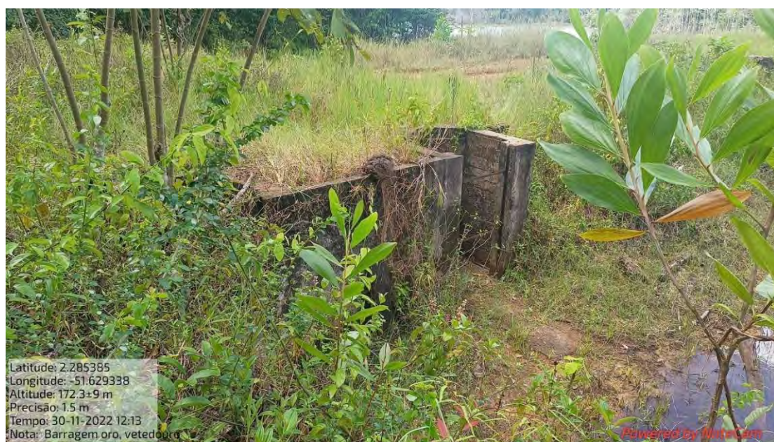
Fotografia 23: Vegetação no vertedouro.
