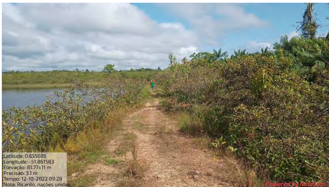
Fotografia 29: Presença de arbustos e vegetação de médio porte na crista e nos taludes da barragem.
