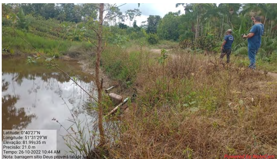
Fotografia 48: Talude de jusante da barragem Deus Proverá.
