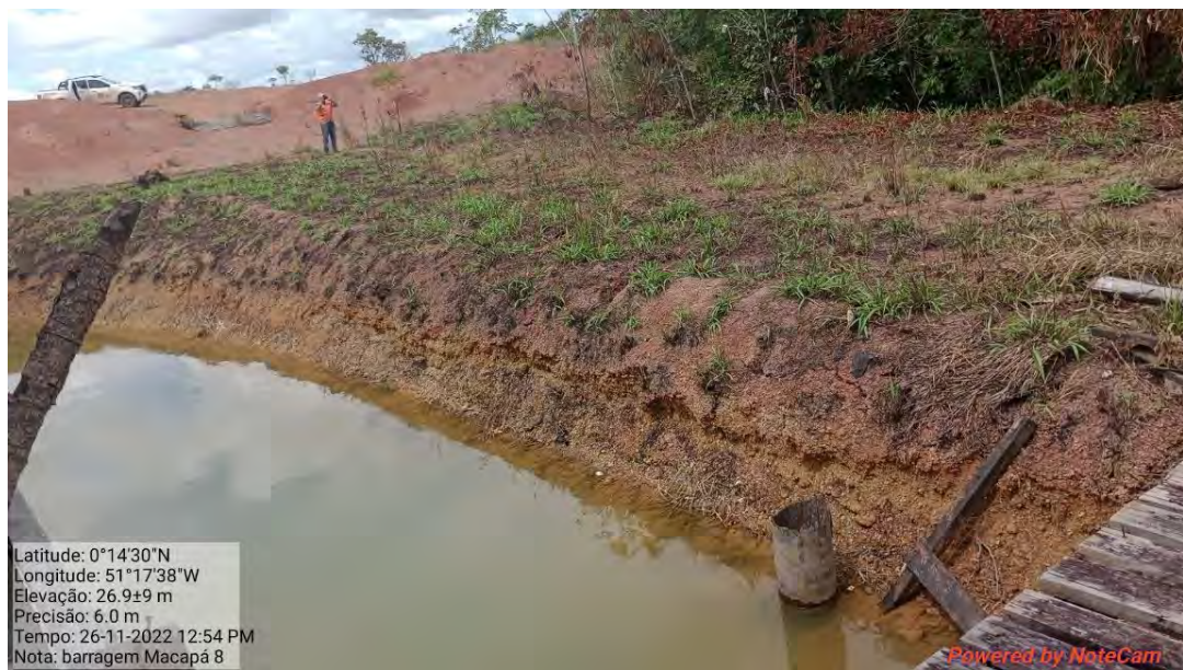
Fotografia 91: Crista do Barramento.
