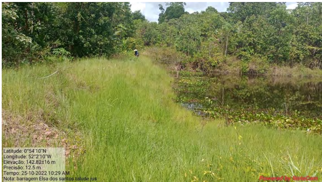
Fotografia 36: Talude de montante.
