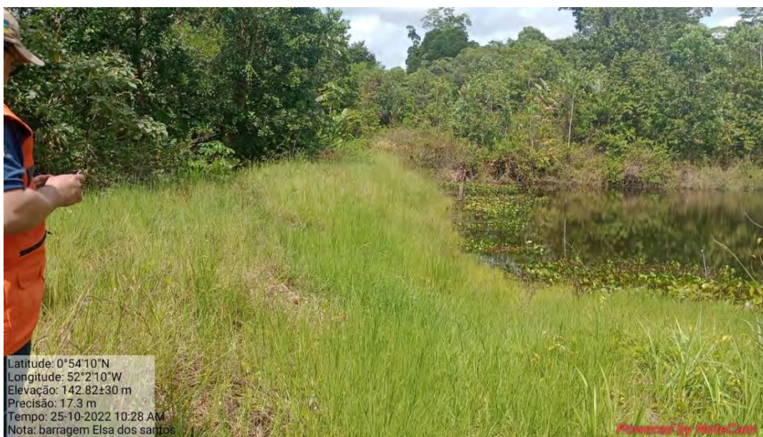
Fotografia 35: Crista da barragem.
