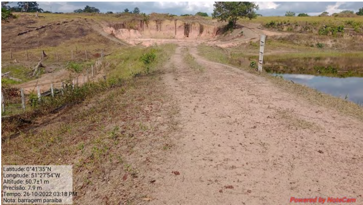
Fotografia 63: Crista da barragem Paraíba.
