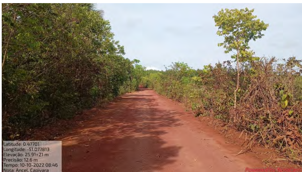
Fotografia 4: Vegetação na crista e nos taludes da barragem.
