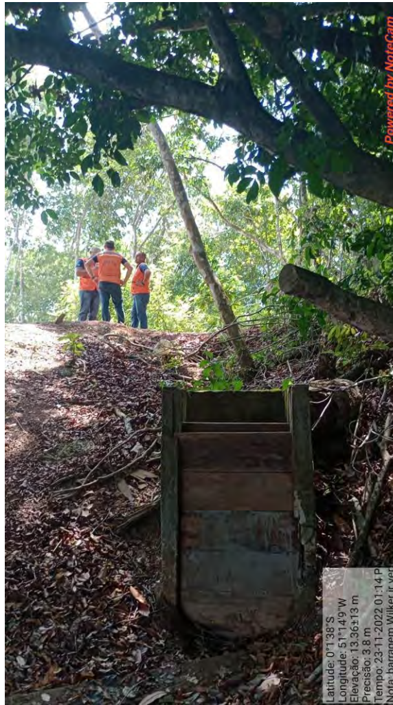
Fotografia 84: Extravasor de uma possível paragem abandonada. Onde liga a topografia do terreno com os tanques de barramento atual.
