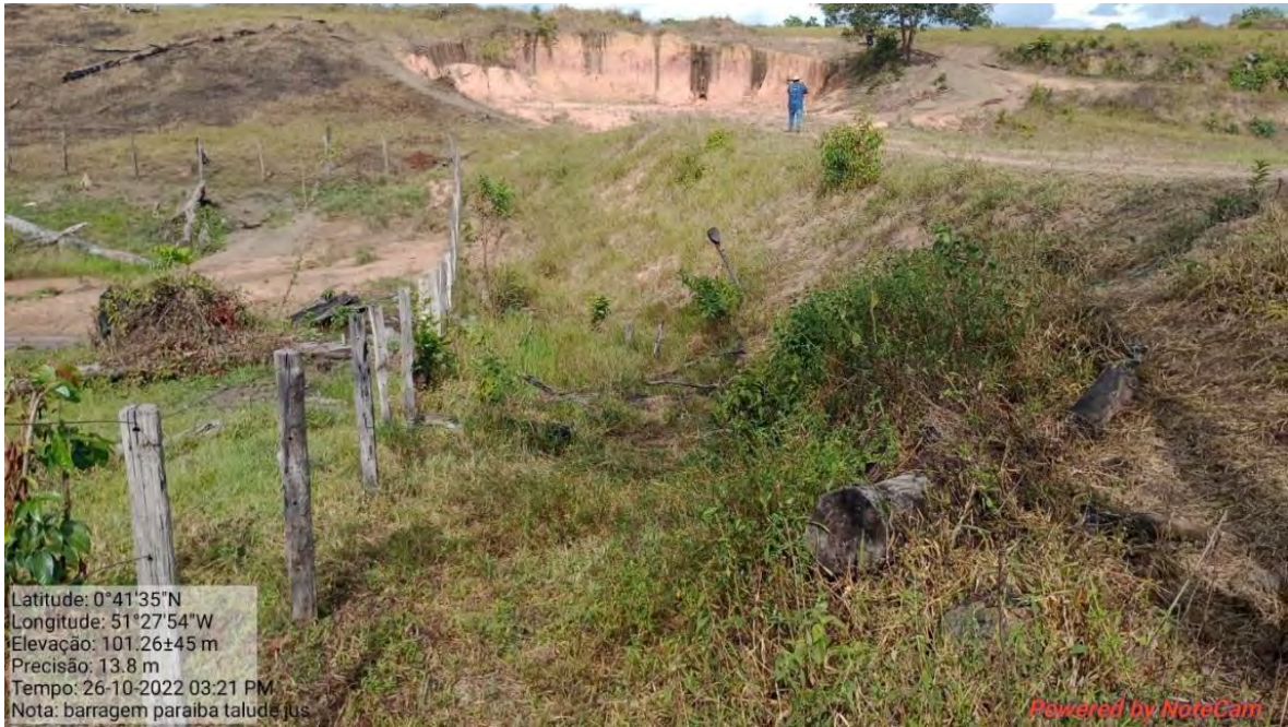
Fotografia 59: Talude de jusante da barragem Paraíba.
