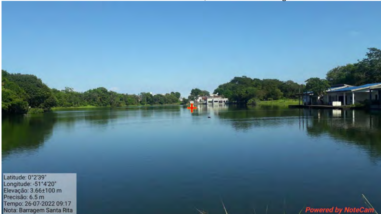
Foto 1/8 – Vista do Reservatório, a montante da barragem
