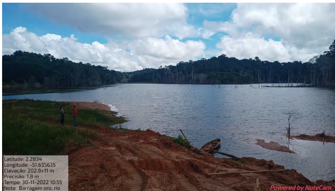
Fotografia 24: Depósito de rejeito na região à jusante da Barragem Oro, oriundo na cooperativa Coogal.
