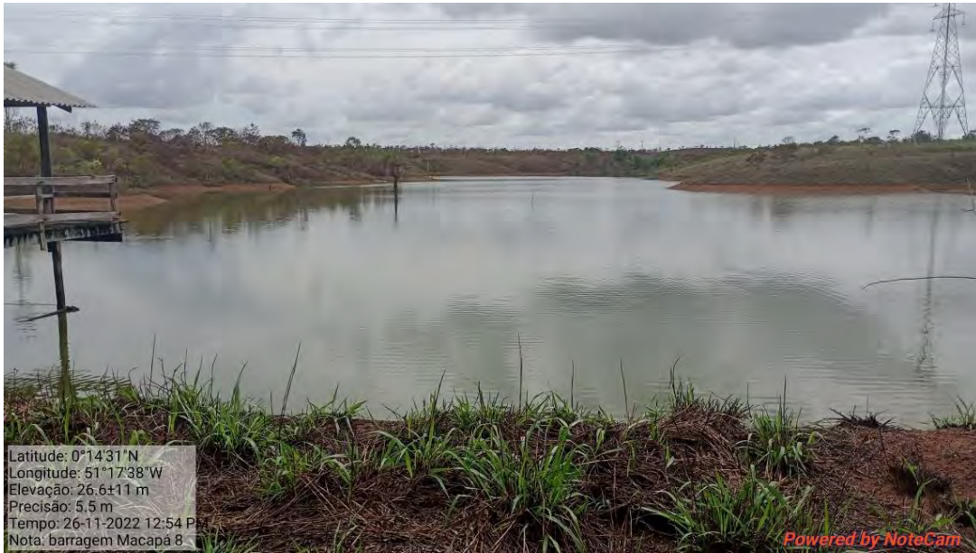
Fotografia 90: Reservatório da barragem.
