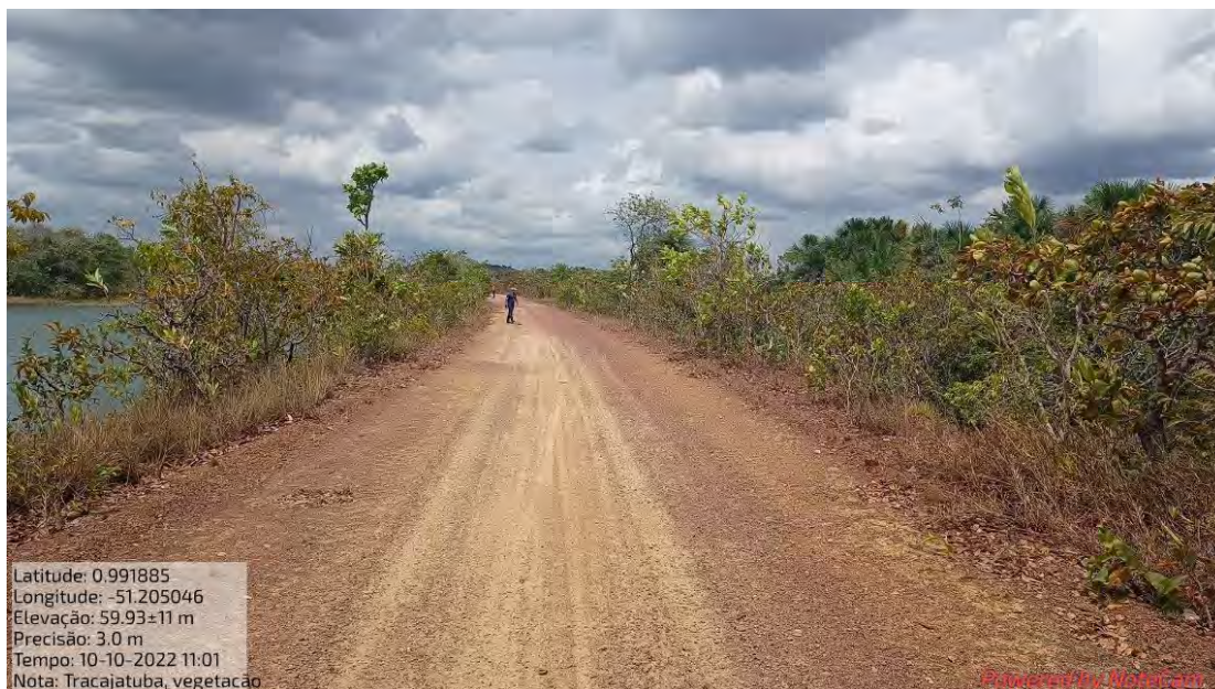
Fotografia 5: Árvores e arbustos nos taludes à montante e jusante da barragem.
