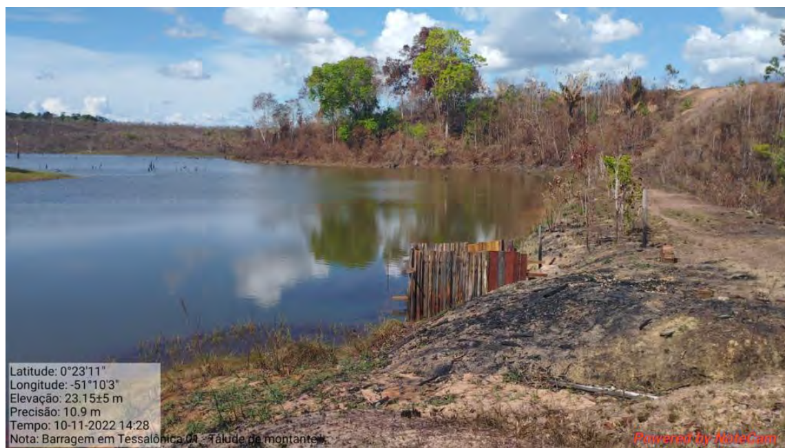
Fotografia 80: Talude montante com vegetação e extravasor em madeira.
