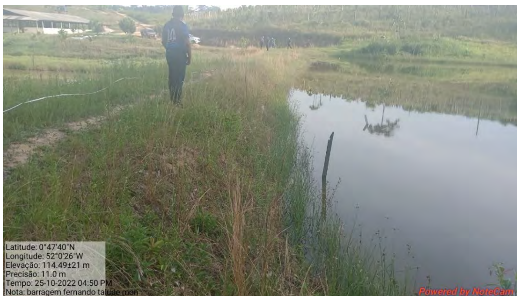
Fotografia 43: Talude de montante da barragem Desconhecida 3- Fernando Duarte.
