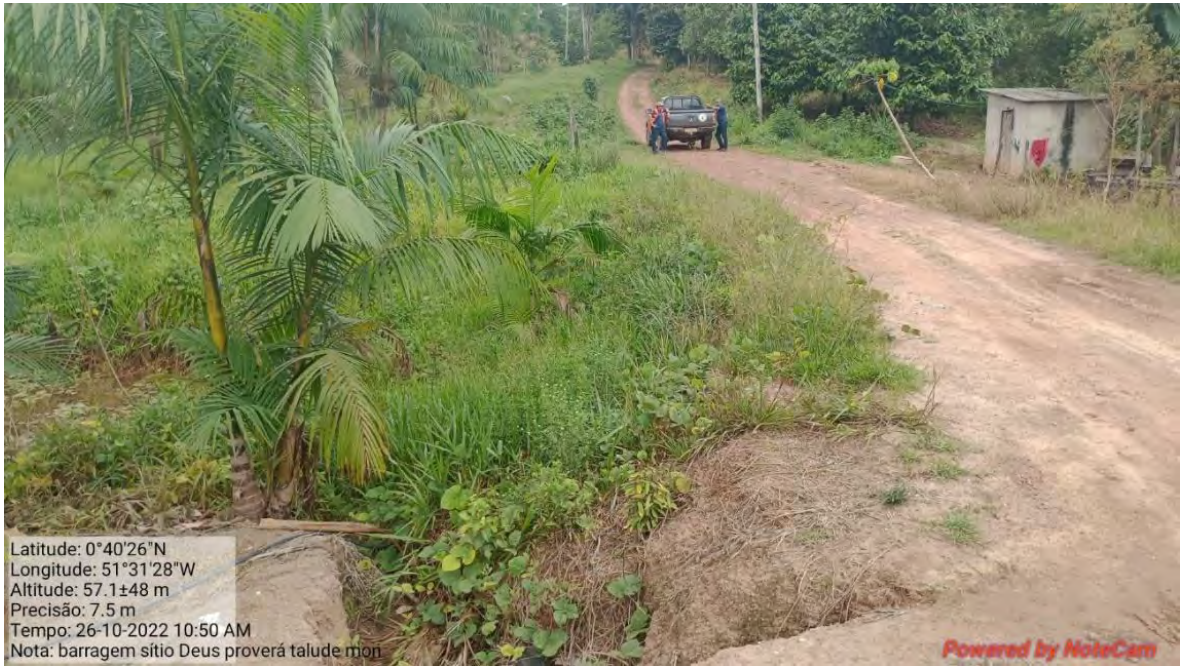
Fotografia 49: Talude de montante da barragem Deus Proverá.
