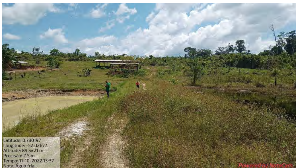
Fotografia 11: Vista da barragem e do tanque de piscicultura.
