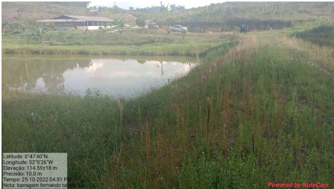
Fotografia 44: Talude de jusante da barragem Desconhecida 3- Fernando Duarte.
