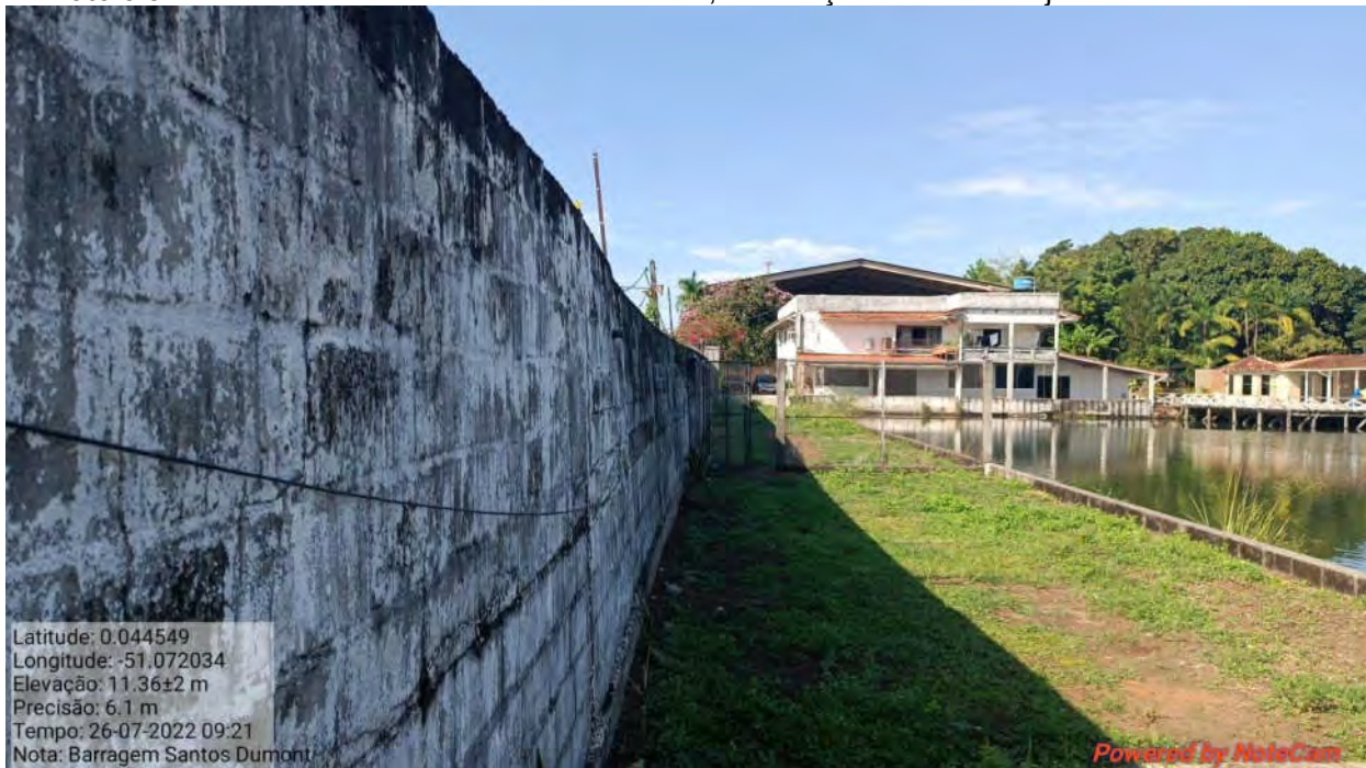
Foto 3/8 – Detalhe do abaulamento do muro divisa, em direção ao talude de jusante – lado interno
