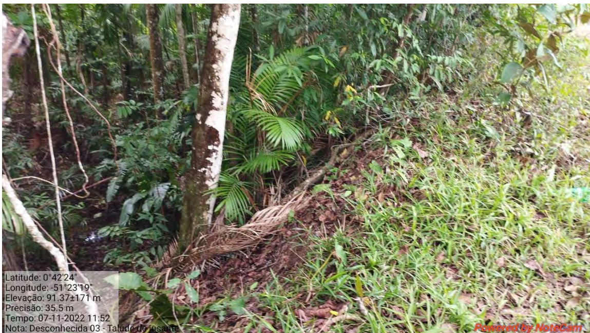
Fotografia 71 - Talude jusante da barragem desconhecida 3 com vegetação.
