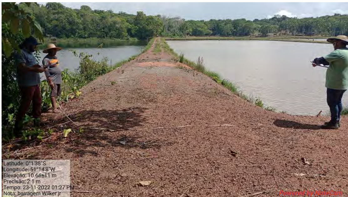
Fotografia 83: Crista da Barragem Principal.
