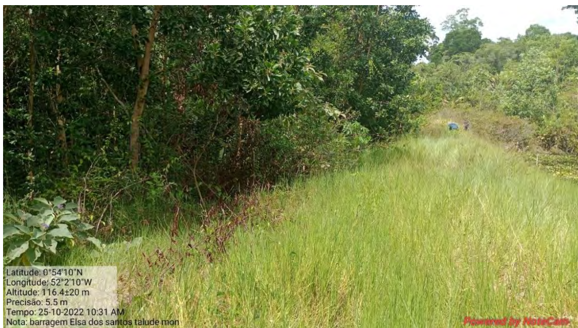
Fotografia 37: Talude de jusante da barragem.
