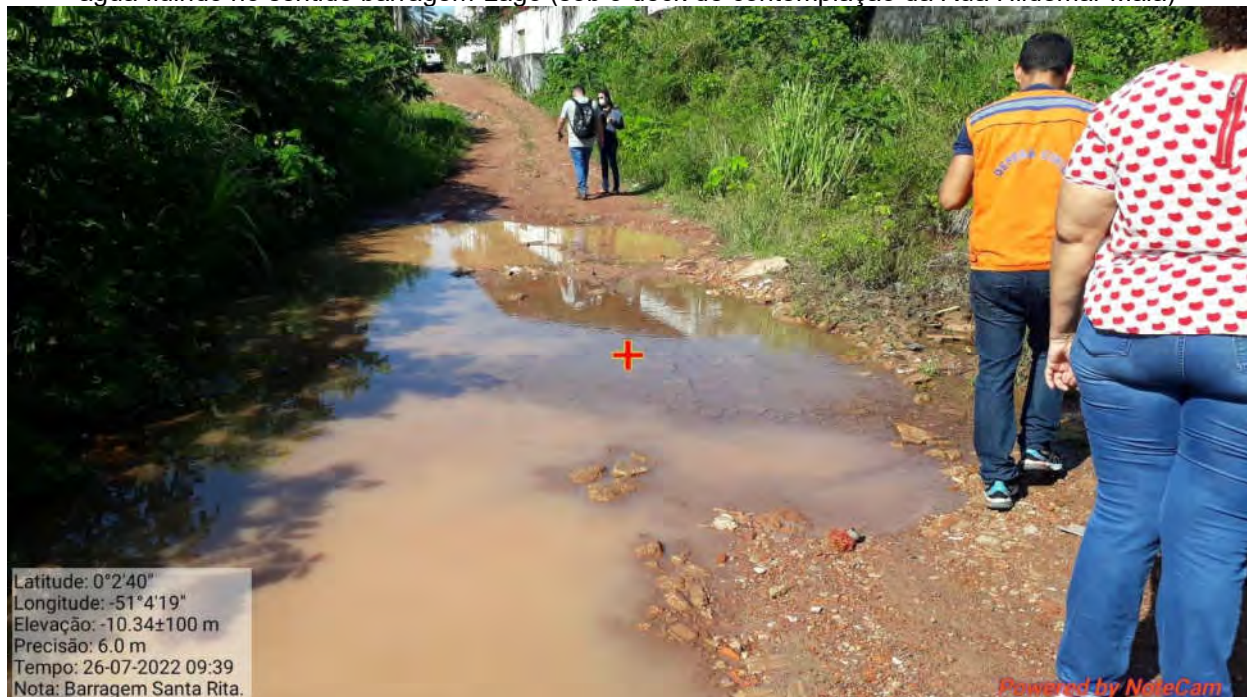
Foto 8/8 – Trecho da Rua Santos Dumont paralelo ao comprimento da barragem – detalhe da lâmina de água fluindo no sentido barragem-Lago (sob o deck de contemplação da Rua Hildemar Maia)
