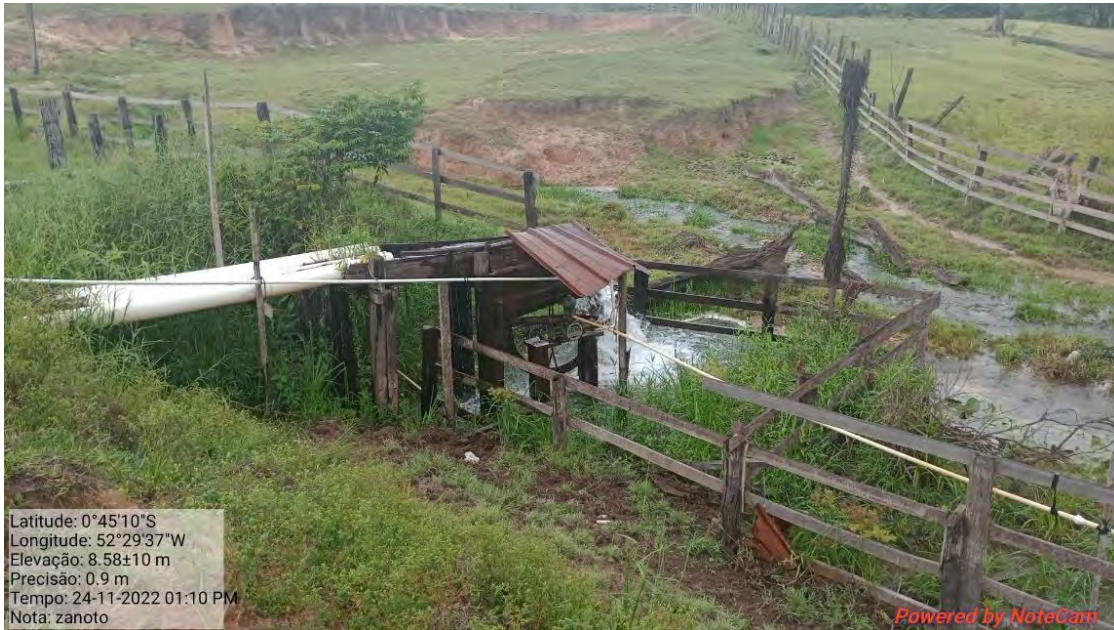
Fotografia 89: Saída do tubo Fotografia e extravasor com vegetação.
