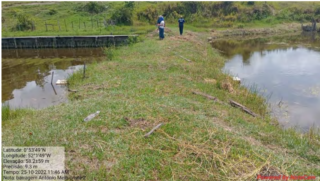
Fotografia 39: Crista barragem 2 Antônio Melo.
