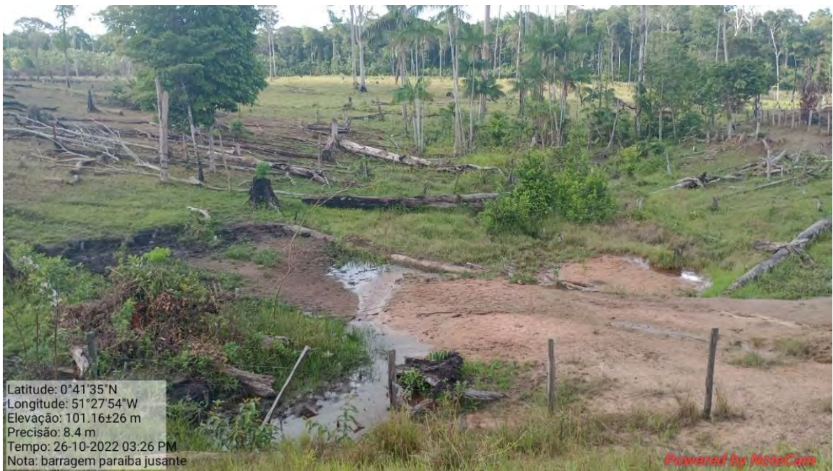
Fotografia 60: Região a jusante da barragem Paraíba.
