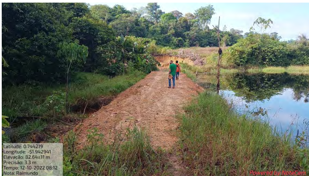
Fotografia 34: Aterramento da crista com material retirado das proximidades da ombreira direita.
