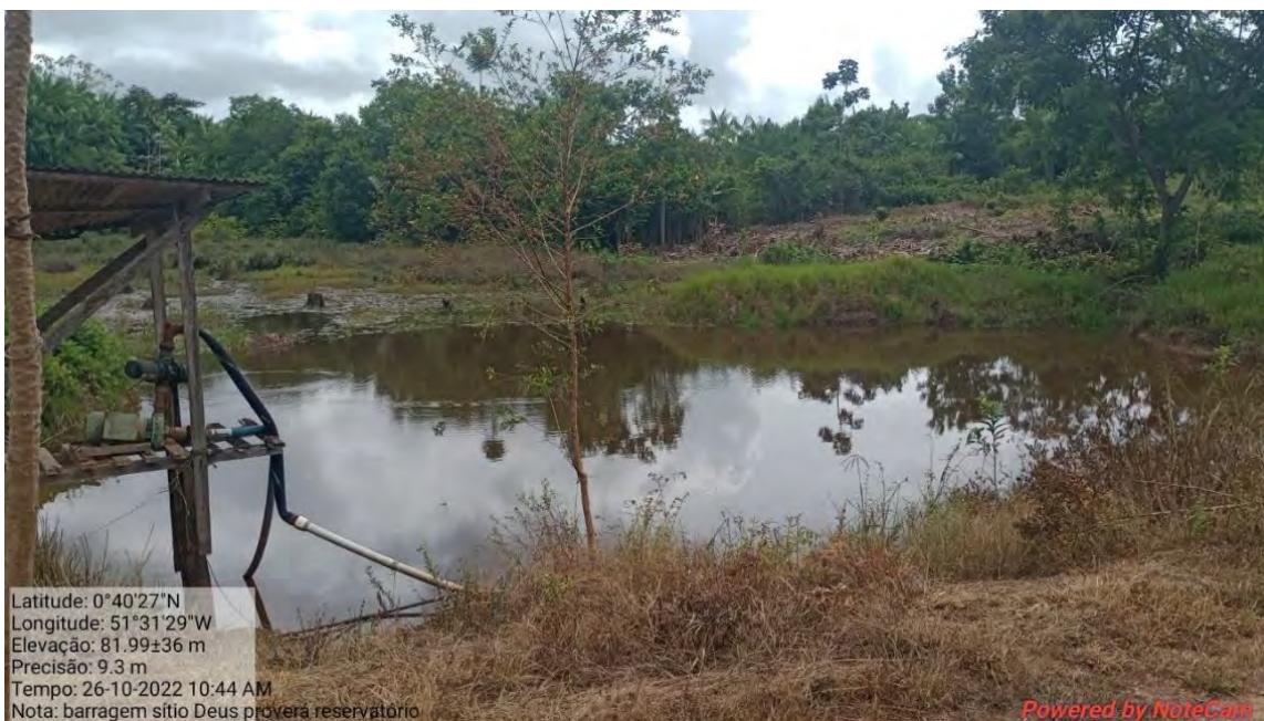
Fotografia 53: Região a jusante do reservatório da barragem Deus Proverá.
