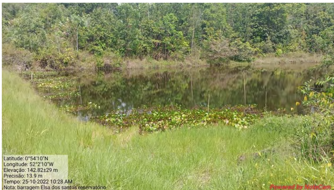
Fotografia 38: Reservatório da barragem.
