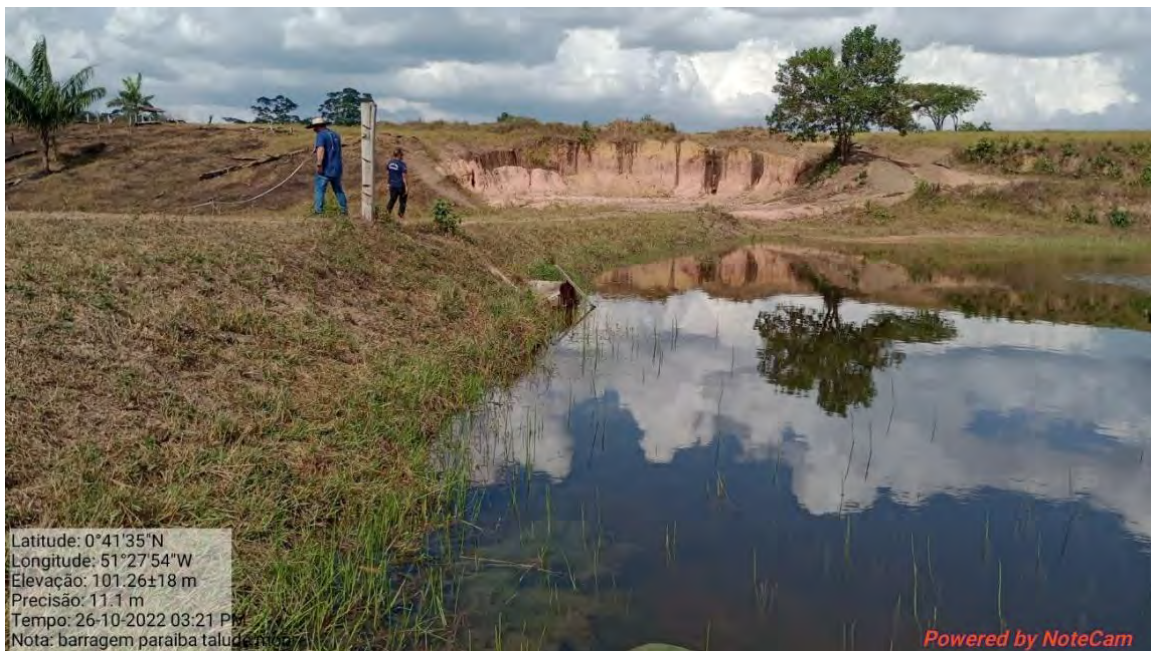
Fotografia 58: Talude de montante da barragem Paraíba.
