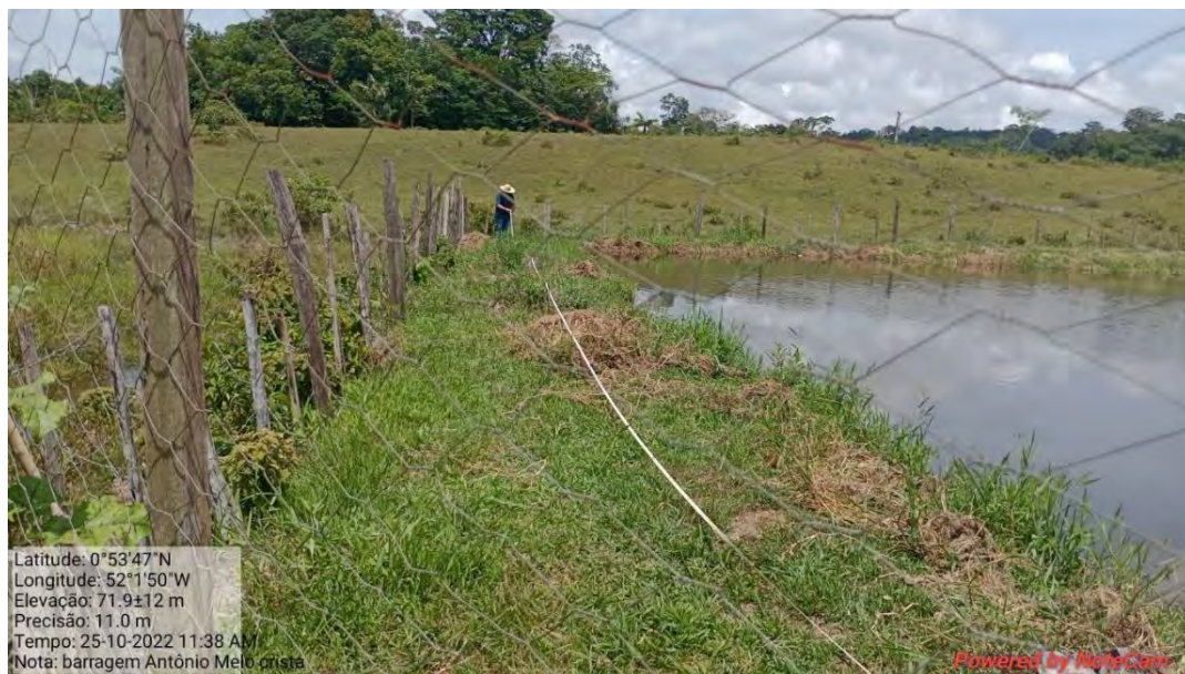
Fotografia 40: Crista da barragem Antônio Melo
