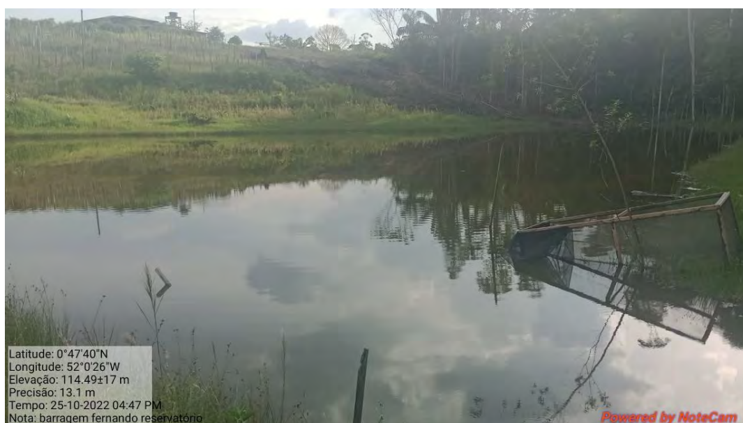
Fotografia 47: Reservatório da barragem Desconhecida 3- Fernando Duarte.
