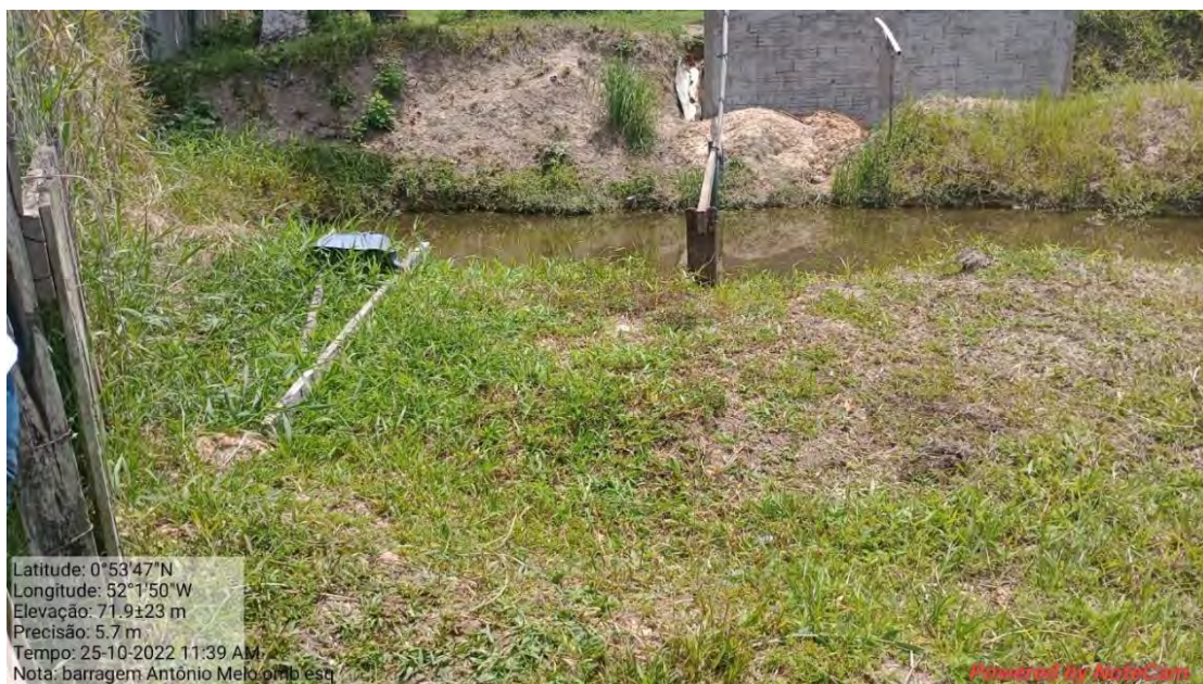
Fotografia 41: Ombreira esquerda barragem 1 Antônio Melo.
