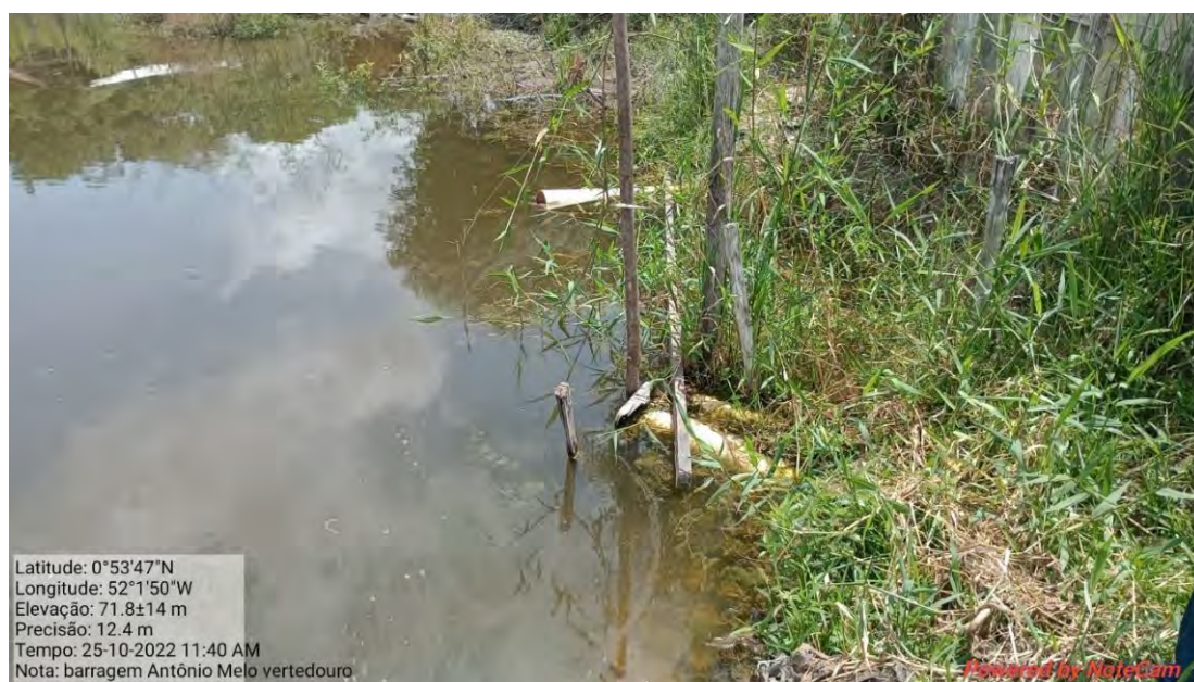
Fotografia 42:-Vertedouro da barragem Antônio Melo.
