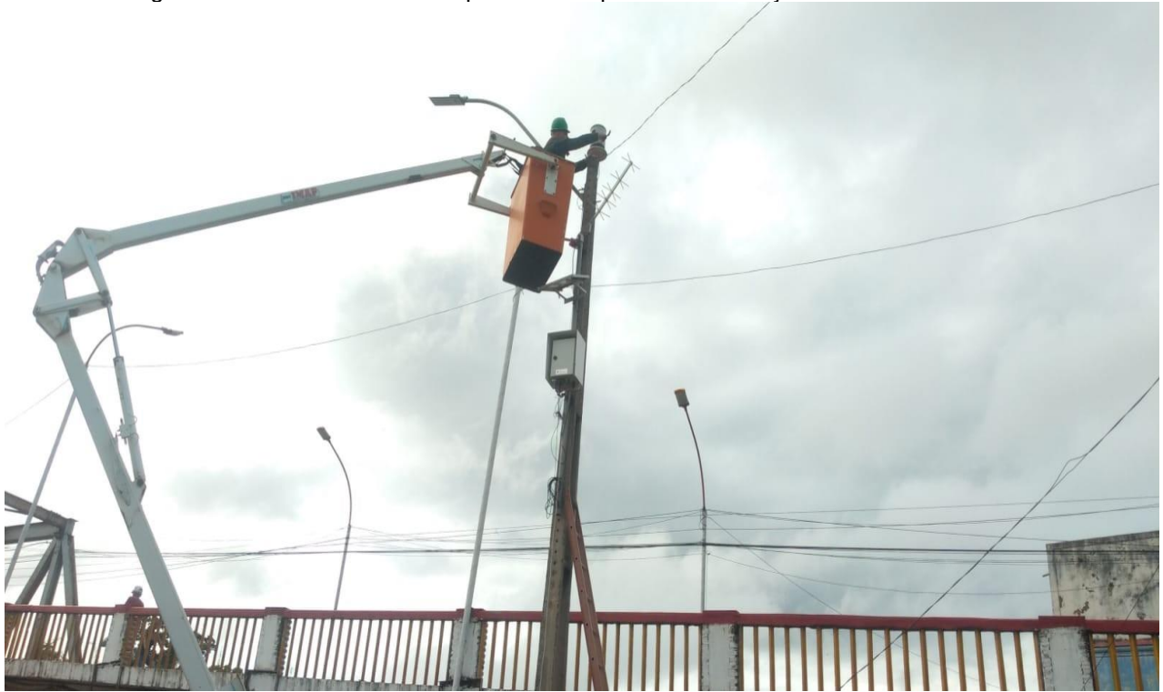
Figura 9 - Caminhão Munck disponibilizado para a manutenção da PCD Pedreiras II
