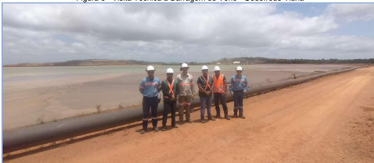
Figura 6 - Visita Técnica a Barragem do Vené - Godofredo Viana
