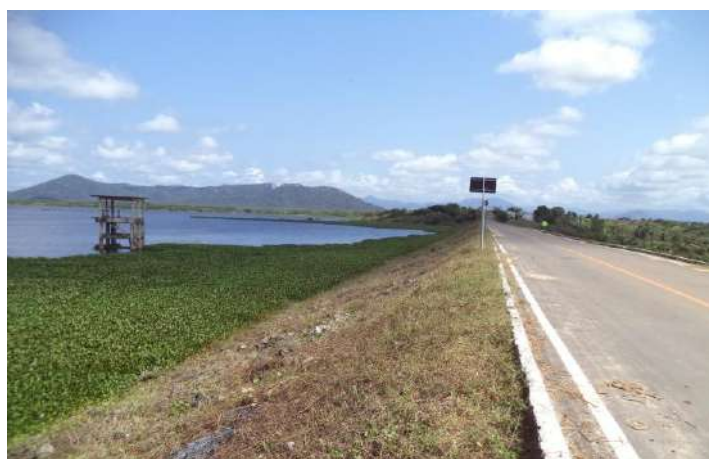
Figura 2 - Barragem Caxitoré, Umirim – CE
