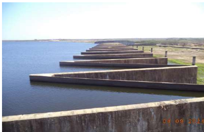
Figura 1 - Barragem Batente, Ocara – CE
