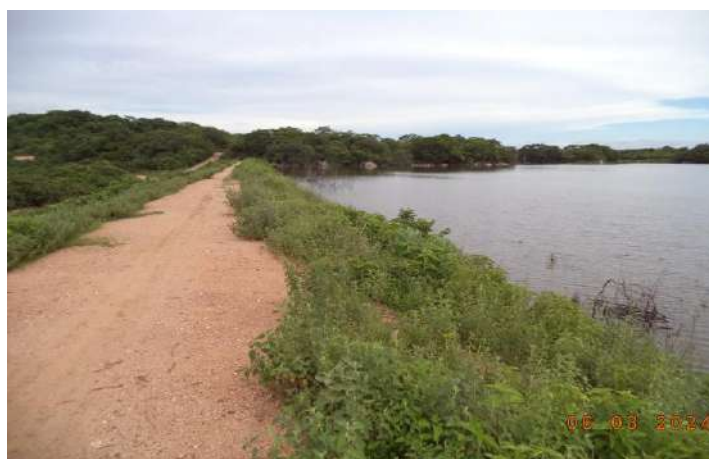
Figura 18 - Barragem Boa Vista dos Mirandas, Santa Quitéria - CE
