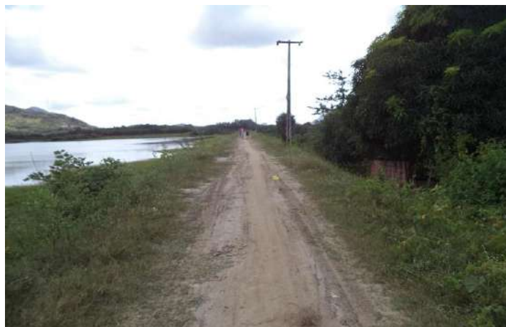
Figura 7 - Barragem São Joaquim, Umirim - CE
