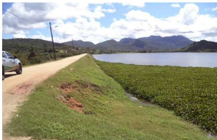
Figura 6 - Barragem Penedo, Maranguape – CE
