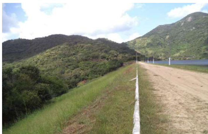
Figura 4 - Barragem Mundaú, Uruburetama – CE
