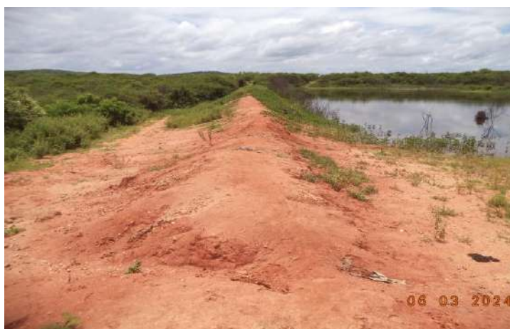
Figura 17 - Barragem Jurema, Nova Russas - CE
