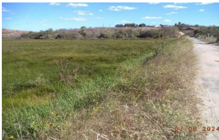
Figura 8 - Barragem Neto da Barra, Cariús – CE
