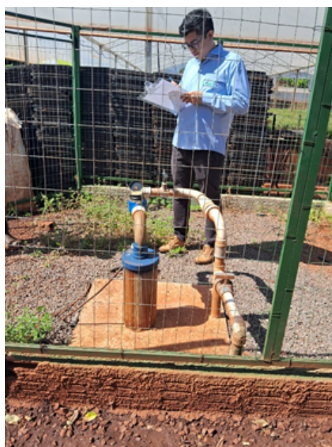
Fiscalização de poço tubular, Sidrolândia, MS
