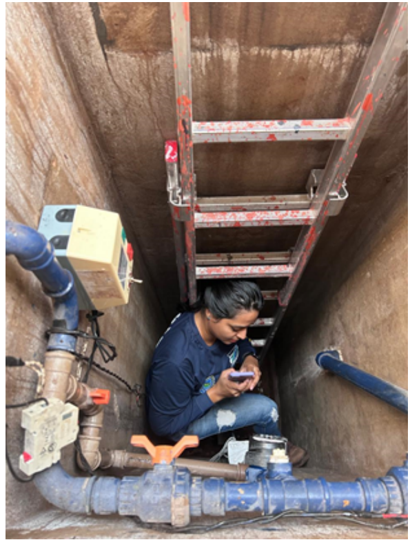
Fiscalização de poço, Campo Grande, MS
