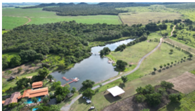
Fiscalização de barragem em atividade turística por drone, Bonito, MS
