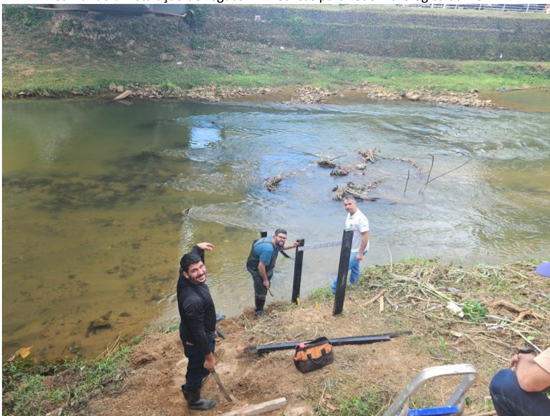
Figura 13 - Equipe em campo da Gerência de Monitoramento Hidrológico e Qualidade das Águas, realizando a instalação de réguas linimétricas para rede hidrológica da AGERH
